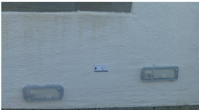
Abbildung 12: Zwei parallel laufende Messungen an der Nordfassade.
