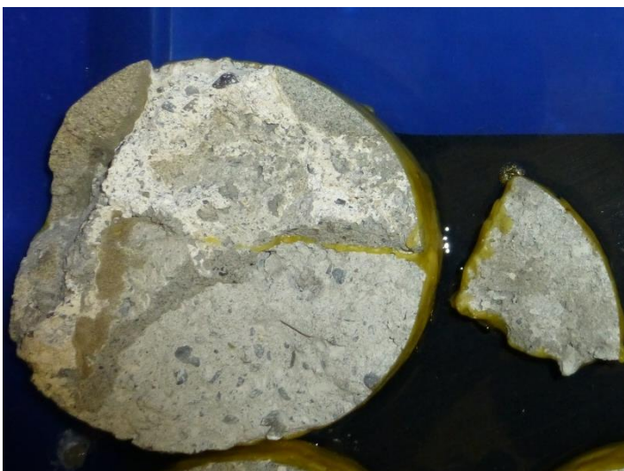
Abbildung 20: Bohrkern mit zwei verschiedenen Putzarten.
