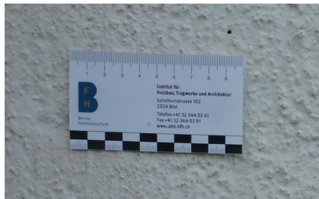
Abbildung 3: Putz der Nordfassade.
