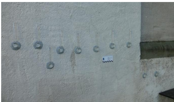
Abbildung 10: Messpunkte 1-10 der Westfassade.
