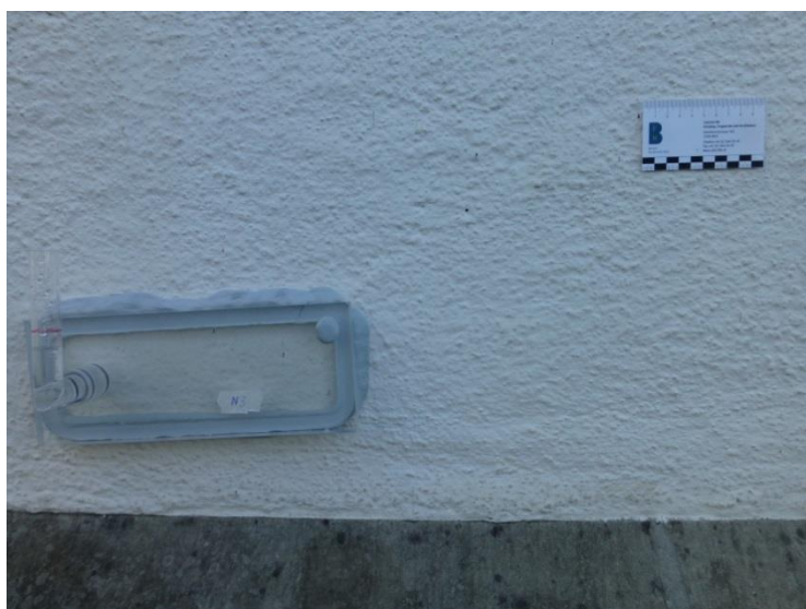
Abbildung 16: Prüfplatte N3 an der Nordfassade.
