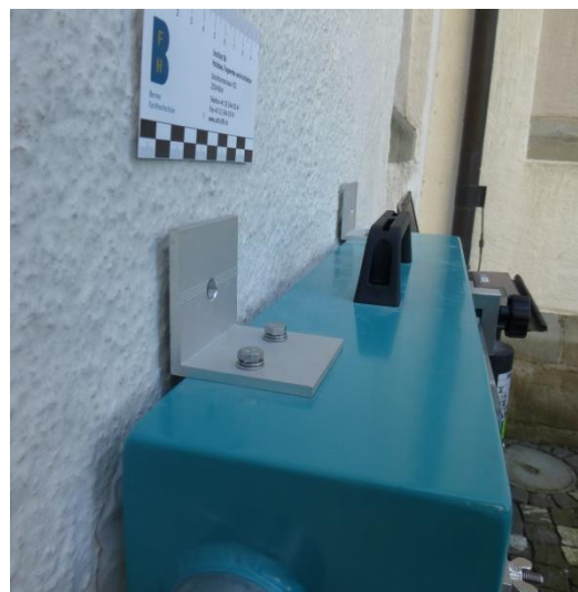
Abbildung 19: Detailaufnahme des WAM's an der Westfassade.
