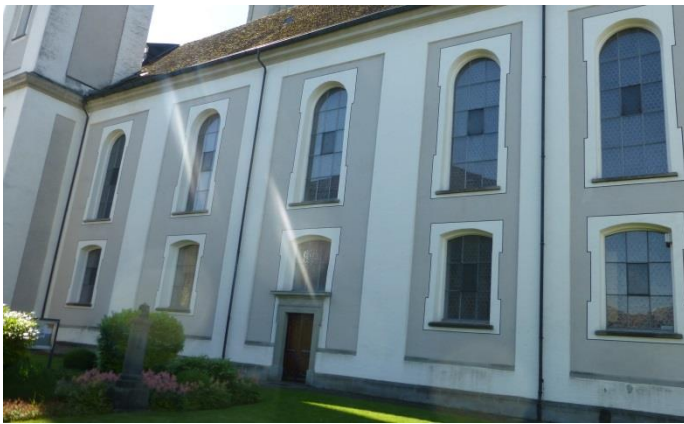
Abbildung 5: Ansicht der Nordfassade.
