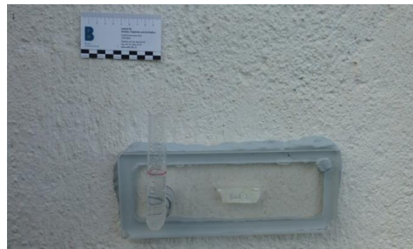
Abbildung 13: Detailaufnahme der Messung N2 an der Nordfassade.
