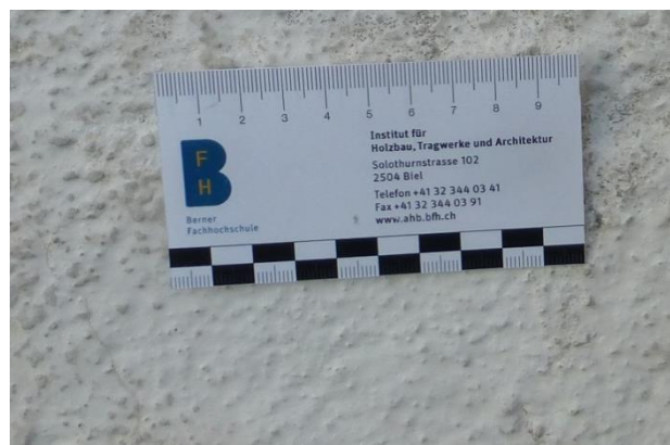
Abbildung 4: Putz der Westfassade.
