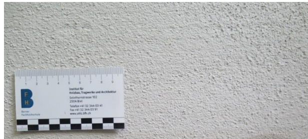
Abbildung 3: Testfassade ohne Farbanstrich.
