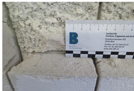
Abbildung 18: Detailaufnahme des Wandaufbaus. Hier mit Deckputz und Farbanstrich.
