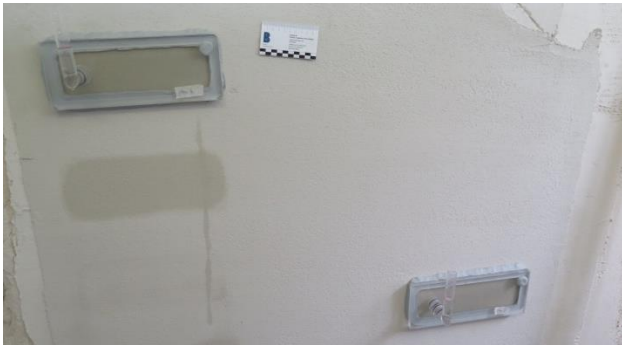
Abbildung 11: Zwei parallel laufende Messungen an der Testfassade ohne Farbanstrich.
