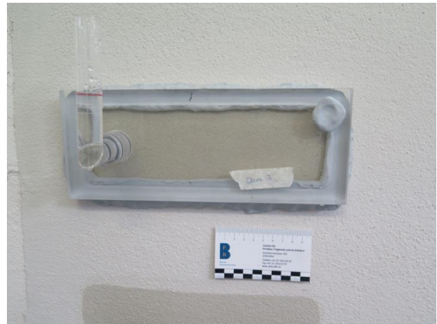
Abbildung 22: Aufgrund der dicken Kittwulst wird der Randeffekt bei der Franke'sche Prüfplatte nicht sichtbar, ist aber dennoch vorhanden.
