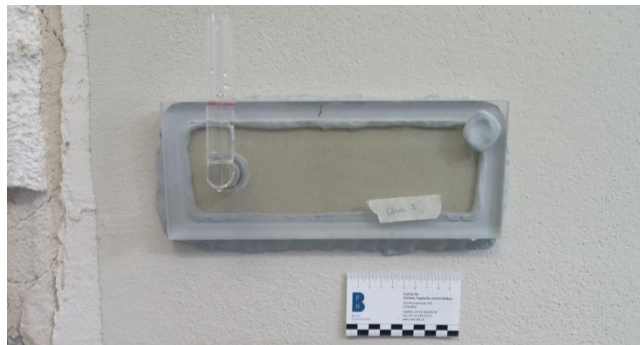
Abbildung 12: Detailaufnahme der Messung Ohne 3 an der Testfassade ohne Farbanstrich.
