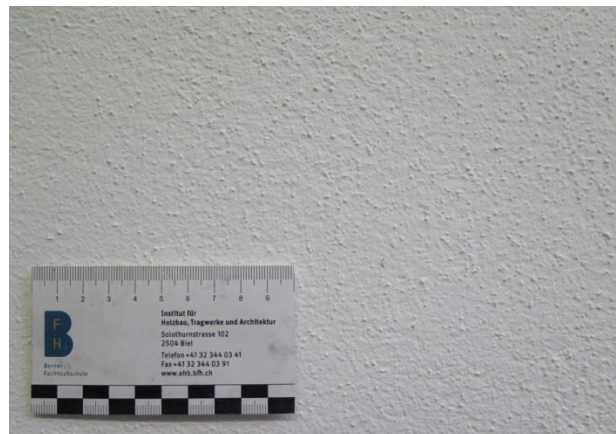
Abbildung 4: Testfassade mit Farbanstrich.
