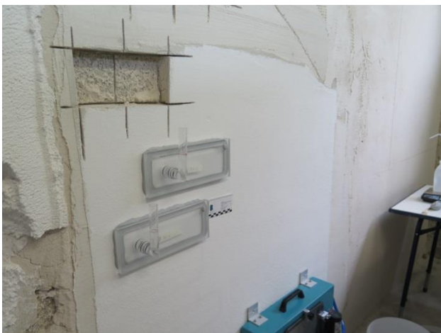
Abbildung 13: Zwei parallel laufende Messungen an der Testfassade mit Farbanstrich.
