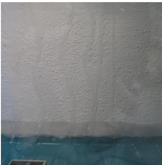
Abbildung 16: Bildung von Fließbereichen durch den hydrophobierten Anstrich und Körnung.
