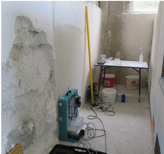
Abbildung 5: Ansicht der Testfassade. Hier ohne Farbanstrich.
