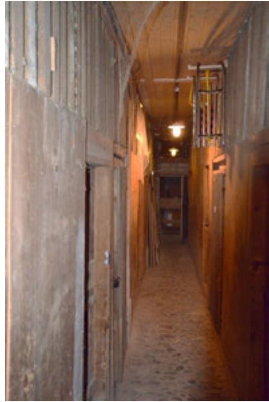
Abbildung 79 , mit Holzverschlügen abgetrennte Keller- und Lagerräume, auch hier finden sich durchgehend die mächtigen Stützpfiler und die Pflasterung.
