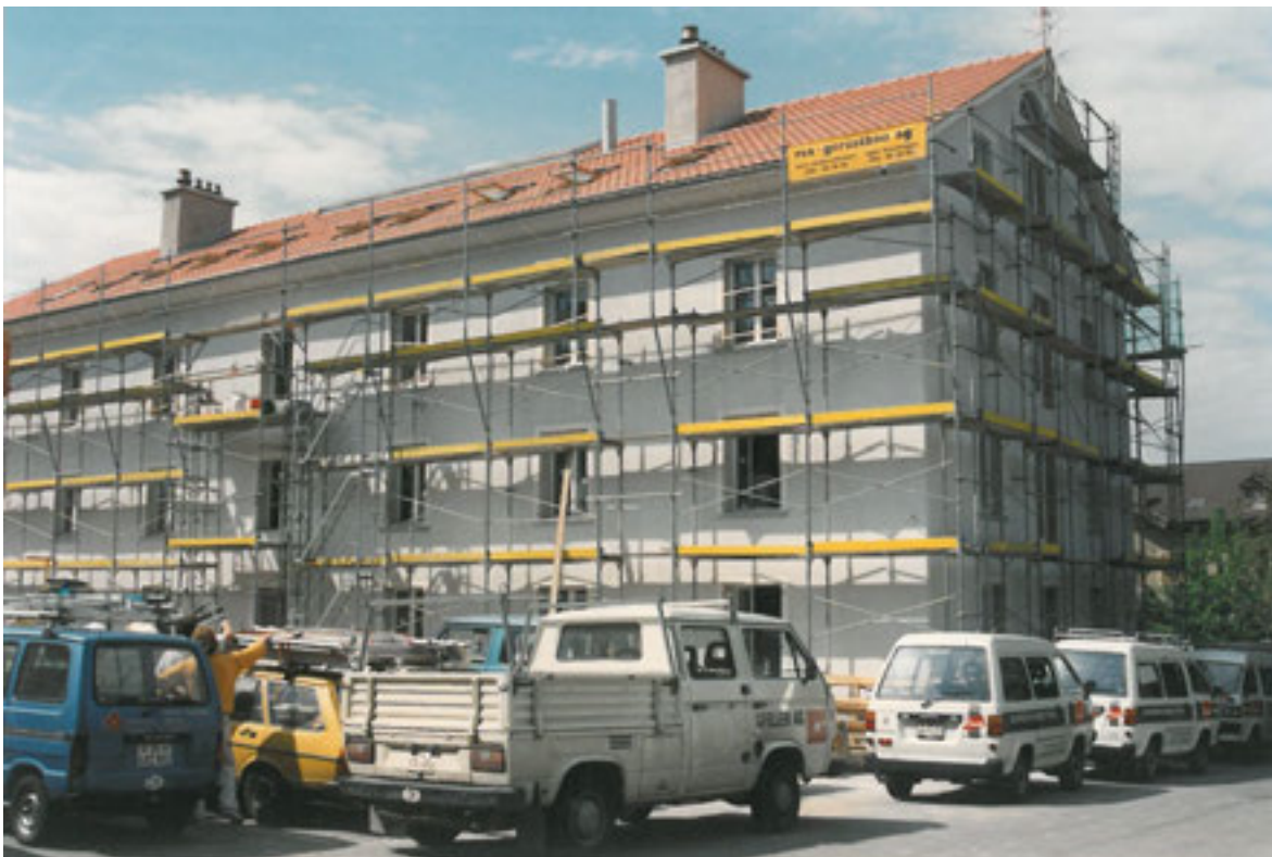
Abbildung 88 , Aufnahme während des Umbaus 1994. (aus Kurzinventar Turgi)
