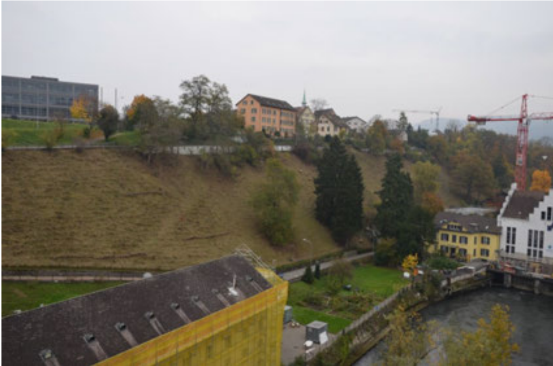
Abbildung 29 , Gesamtsituation von der Hochbrücke aus gesehen, (Foto H. Dobler Nov. 2013)
