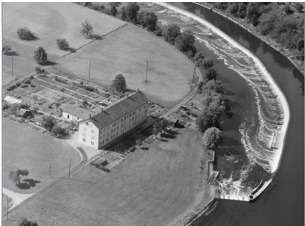
Abbildung 177 , Bildausschnitt einer Luftaufnahme von 1964. einzig noch erhaltenes Kosthaus an der Limmatstrasse, in den rückwärtigen Nutzgärten steht rechtwinklig zum Hauptbau das eingeschossige Waschhaus, rechts das Streichwehr welches das Wasser zur weiter nördlich liegenden Fabrik Stroppele führt. (ETH-Bibliothek Zürich, Bildarchiv, Fotograf Comet Photo AG, Zürich)
