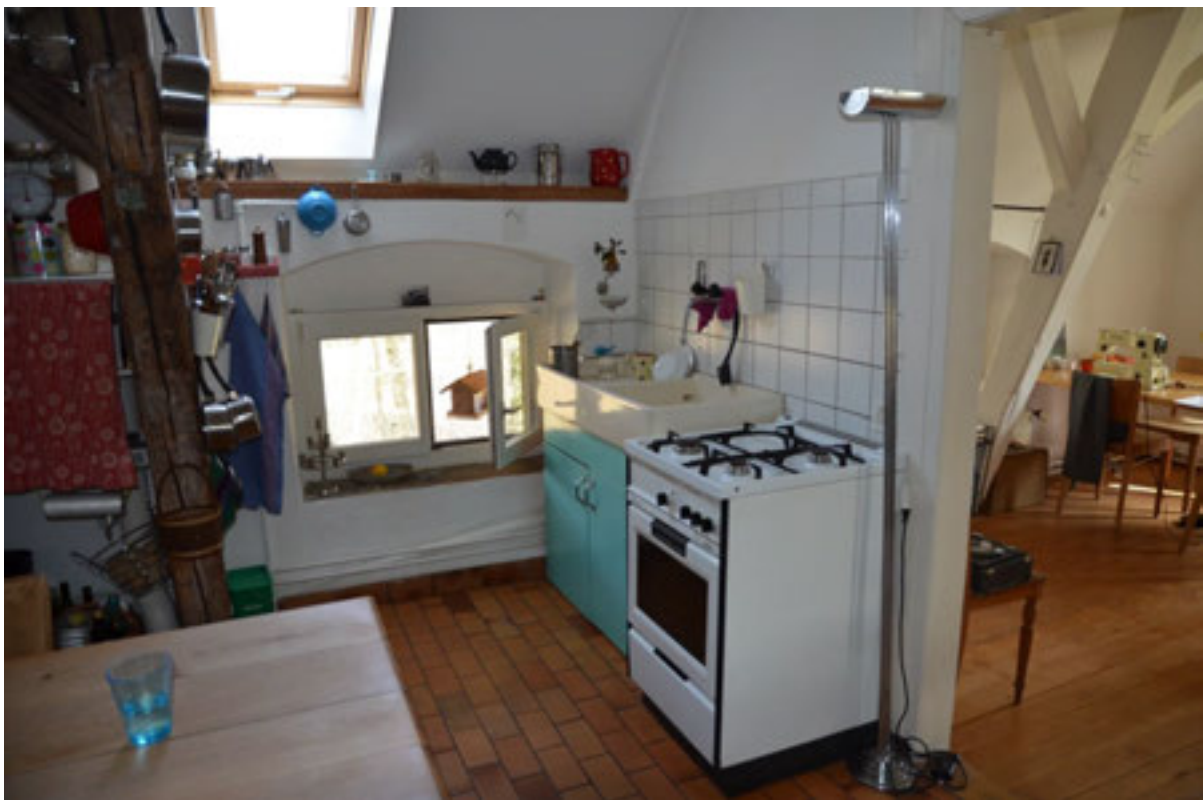
Abbildung 111 , Küche in der Dachwohnung Ost, nebst dem Sparherd hat erst Ende der 1990er Jahre ein Gasherd Einzug erhalten, bis dahin wurde mit Holz geheizt und gekocht, im hohen Kniestock die ursprüngliche Fensteröffnung, neueres Dachfenster zur zusätzlichen Belichtung. (Foto H. Dobler März 2015)
