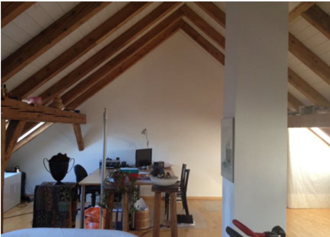
Abbildung 139 , Dachstuhl aus den 1930er Jahren, zu Wohnraum ausgebaut und mittels Dachflächenfenster belichtet. (Foto H. Dobler März 2012)
