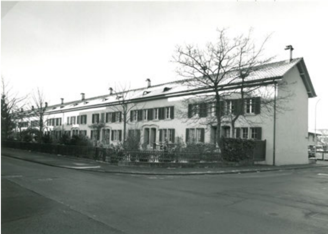
Abbildung 51 , Aufnahme 1993, einige Jahre nach der Renovation (Fotoarchiv Kantonale Denkmalpflege_WET016)
