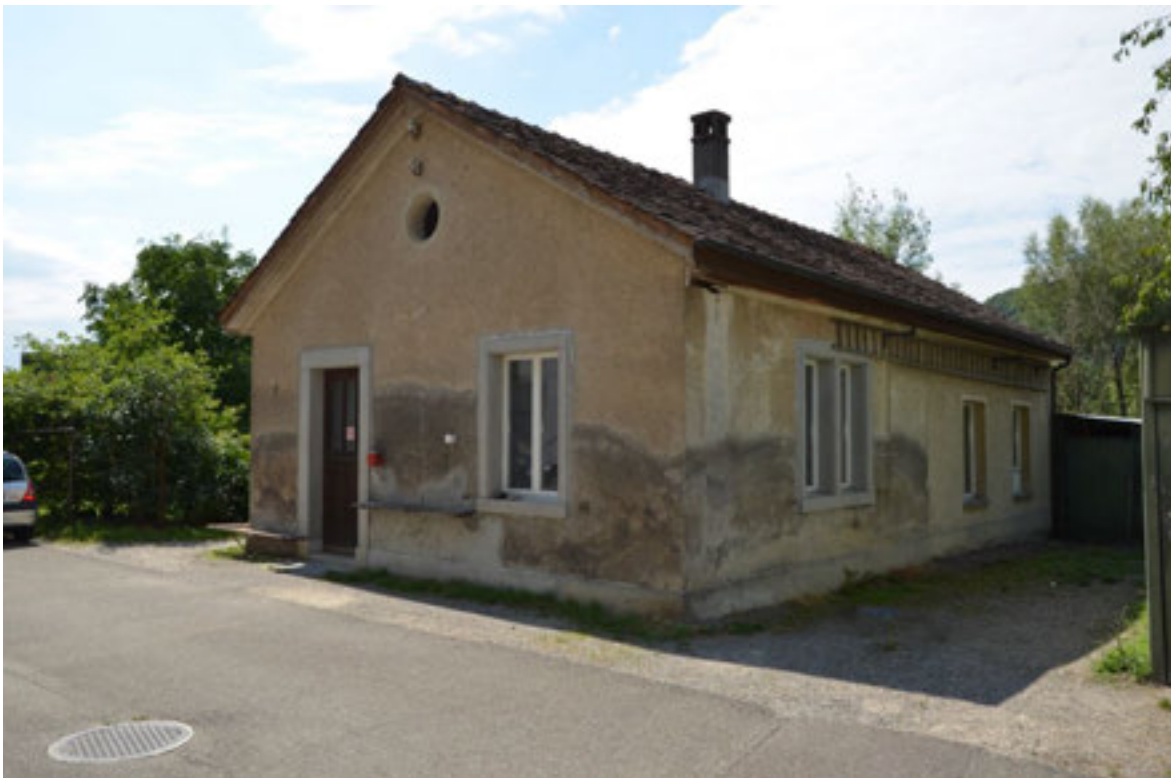
Abbildung 181 , Dem Kosthaus zugehöriges Waschhaus von Nordosten, weitgehend bauzeitlicher Zustand. (Foto H. Dobler, August 2015)
