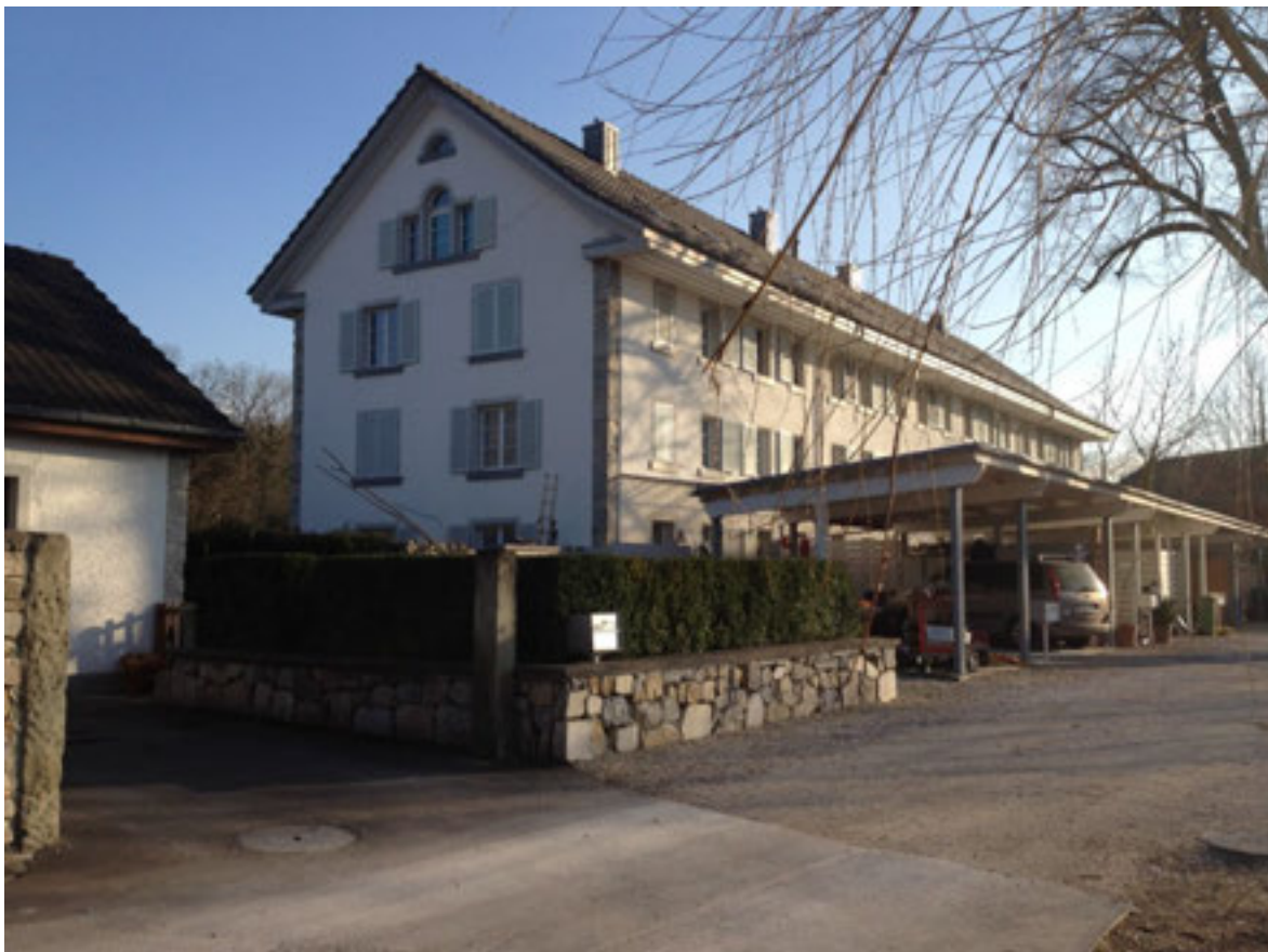
Abbildung 133 , Blick von der Kanalstrasse auf das erste Kosthaus von 1837, vorangestellt neue Autounterstände, gut erkennbar die vom Putz befreiten Eckverbände. (Foto: H. Dobler März 2012)
