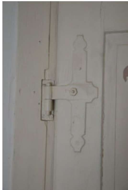
Abbildung 114 , bauzeitliche Türe mit geschmiedeten Beschlägen, unter dem jetzigen Farbanstrich liess sich ein biedermeierliches Grün feststellen. (Foto H. Dobler März 2015)
