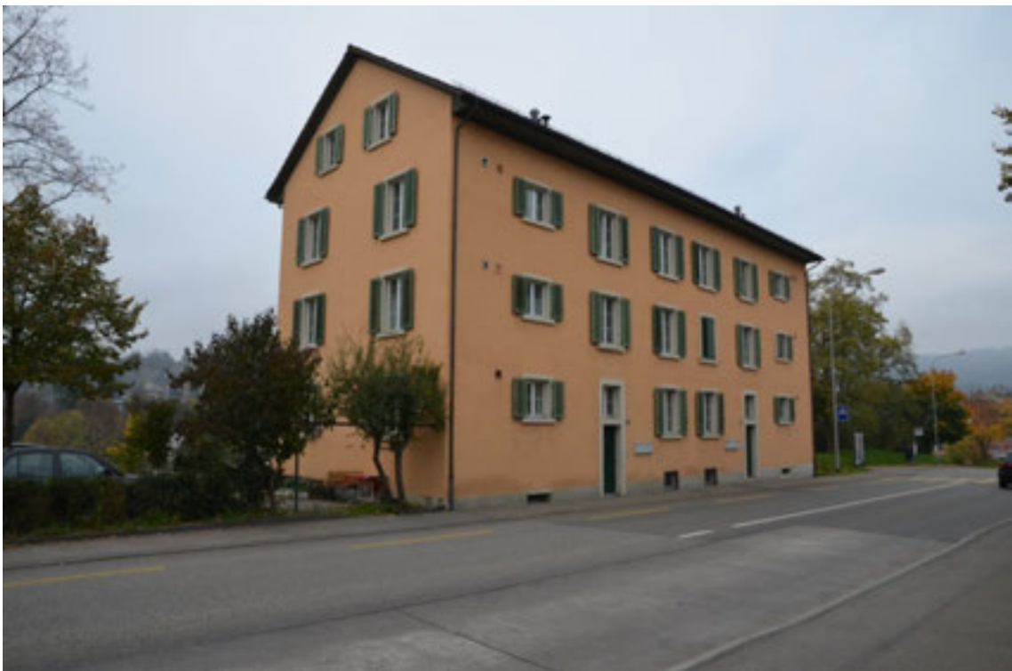
Abbildung 28 , Kosthaus von Südosten (Foto H. Dobler, Nov. 2013)
