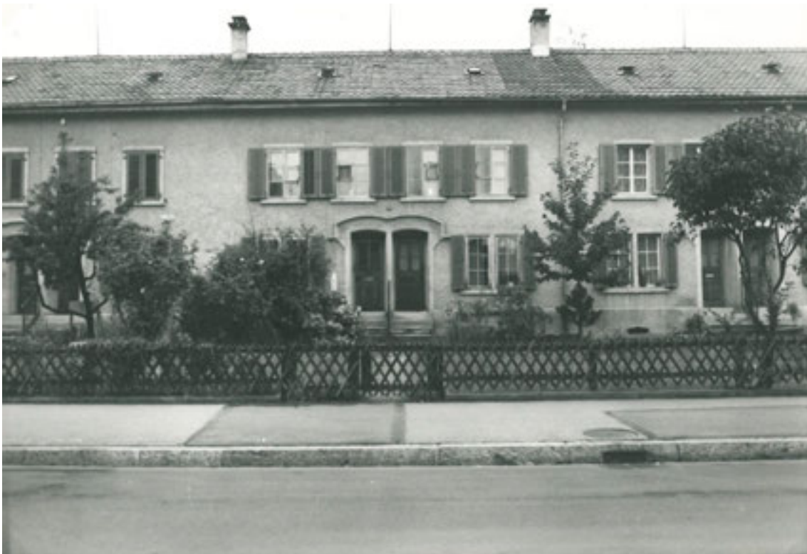
Abbildung 48 , Aufnahme 1982, Ansicht Seite Bahnhofstrasse vor der Renovation, teilweise mit noch historischem Fensterbestand mit Vorfenster (Fotoarchiv Kantonale Denkmalpflege_WET016)
