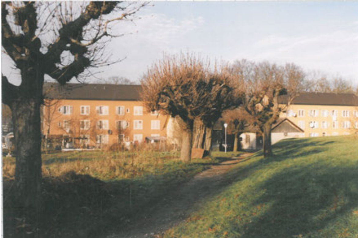
Abbildung 122 , ehem. Fussweg zwischen den Kunz'schen Kosthäusern in Gebenstorf, im Hintergrund die beiden Kosthäuser von 1875, rechts, mit hölzernem Giebel, das noch erhaltene Waschhaus. (Foto aus Kurzinventar Gebenstorf Inv.Nr.913)
