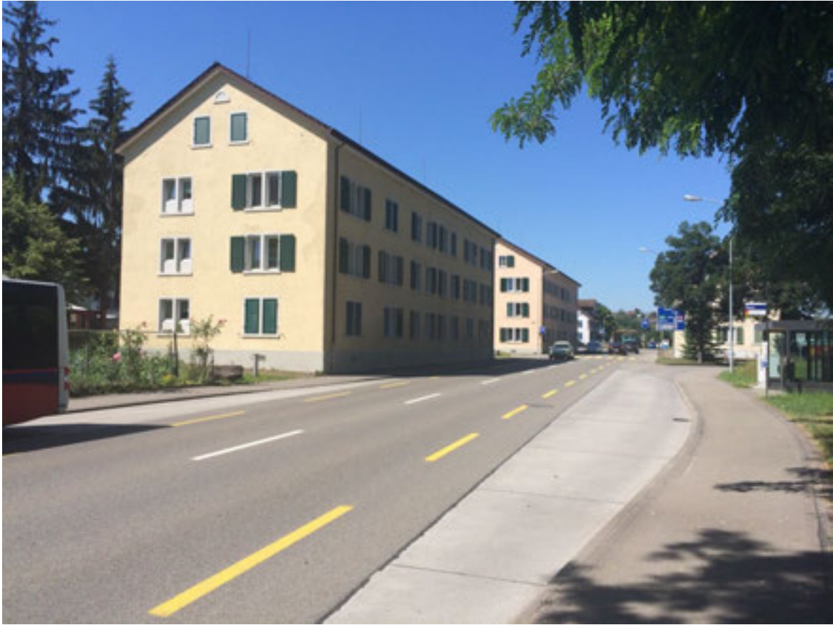
Abbildung 166 , Die beiden Kosthäuser an der Landstrasse prägen noch heute mit ihrer Silhouette hart an der Strasse die Ortszufahrt nach Gebenstorf, Blick von Nordosten. (Foto H. Dobler, Juni 2015)
