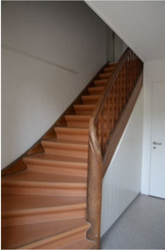
Abbildung 180 , Blick ins Treppenhaus, ursprüngliche Treppe, Stufen mit PVC-Belag belegt, Wohnungseingangstreppe erneuert. (Foto H. Dobler, August 2015)
