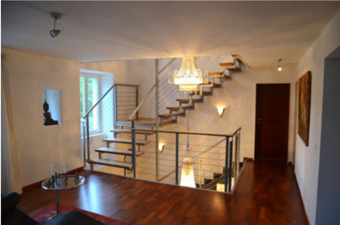
Abbildung 153 , Kosthaus Nr.2, neue Treppenanlage anstelle der früheren einläufigen steilen Stiege. (Foto H. Dobler Oktober 2015)
