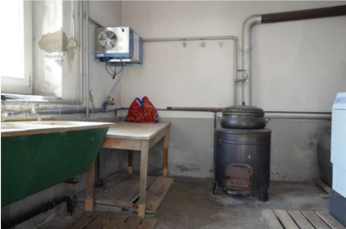
Abbildung 182, Das Waschhaus weist zwei Räume auf, im einen hat sich ein Waschkessel mit Holzfeuerung erhalten. (Foto H. Dobler, August 2015)
