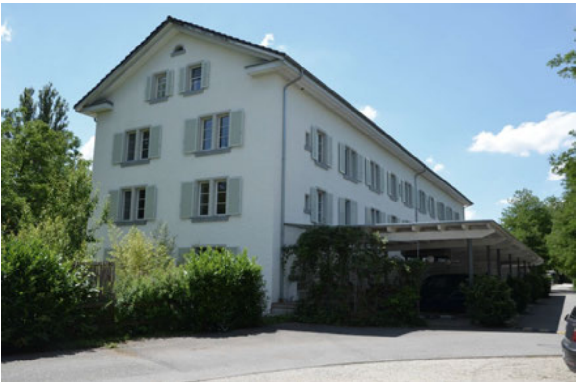
Abbildung 150 , Kosthaus Nr. 2 von Norden, nach der Renovation 2001, vorangestellt die neue Carportanlage. (Foto H. Dobler, Juni 2015)
