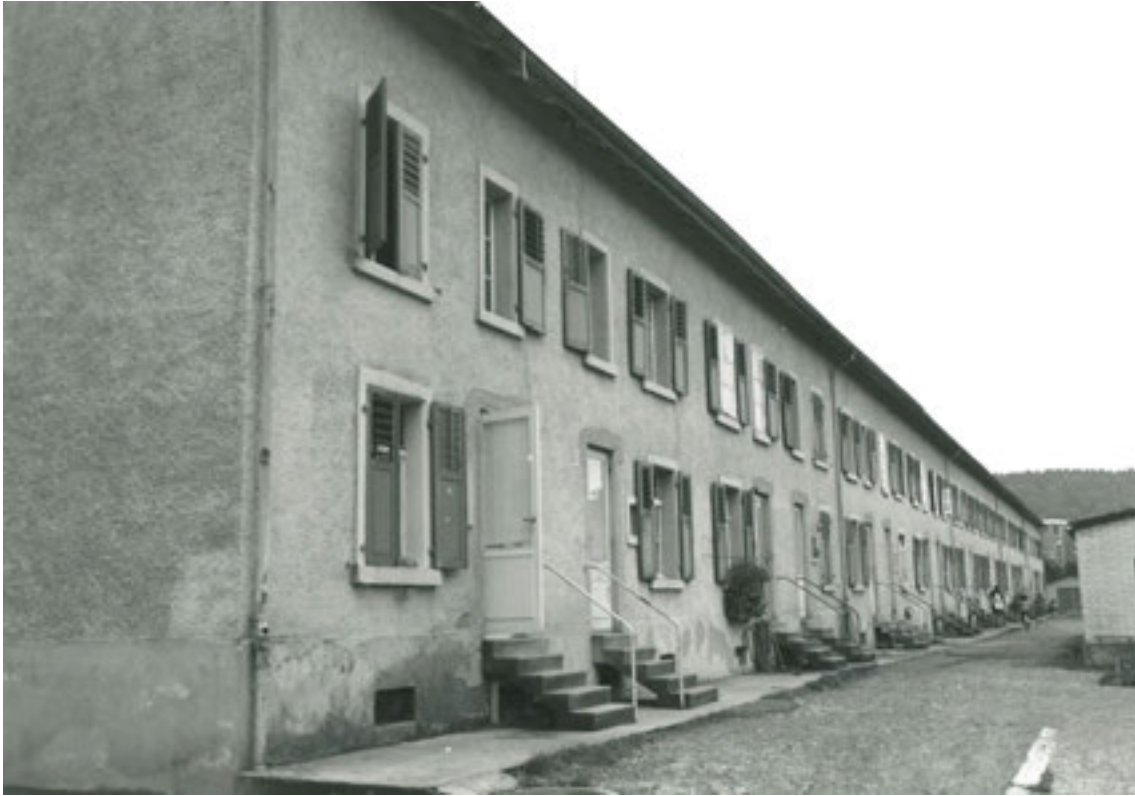
Abbildung 49 , Aufnahme 1982, Rückfassade vor der Renovation (Fotoarchiv Kantonale Denkmalpflege_WET016)
