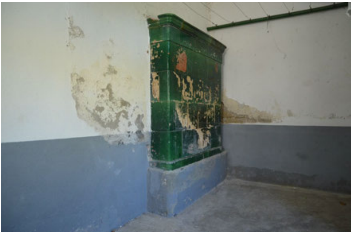
Abbildung 183, im zweiten Raum des Waschhauses haben sich Reste des ursprünglichen Kachelofens erhalten. (Foto H. Dobler, August 2015).
