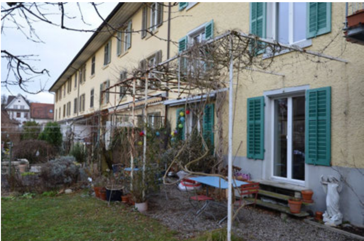
Abbildung 70 , Langhaus Südfassade, die ursprünglichen Fenster wurden in den 80er Jahren bis auf das innere Bodenniveau geführt, um den Zugang zur Gartenzone zu erleichtern, die Schlagläden zeigen die ursprüngliche Brüstungshöhe. Die filigran gestalteten Pergolen sind ebenfalls eine Zutat dieser Umbauphase. (Foto H. Dobler, Januar 2015).
