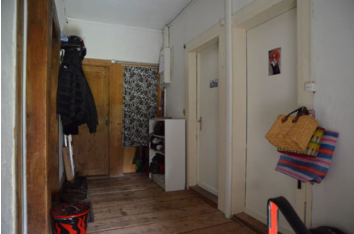
Abbildung 107 , Vorbereich im Treppenhaus, Blick zu den holzsichtigen Türen zu den früheren Abortanlagen, rechts und links je zwei Eingänge zu den Wohnungen, zur Küche und zu einem Zimmer, Türblätter teils erneuert, ursprüngliche Bodendielen. (Foto H. Dobler März 2015)
