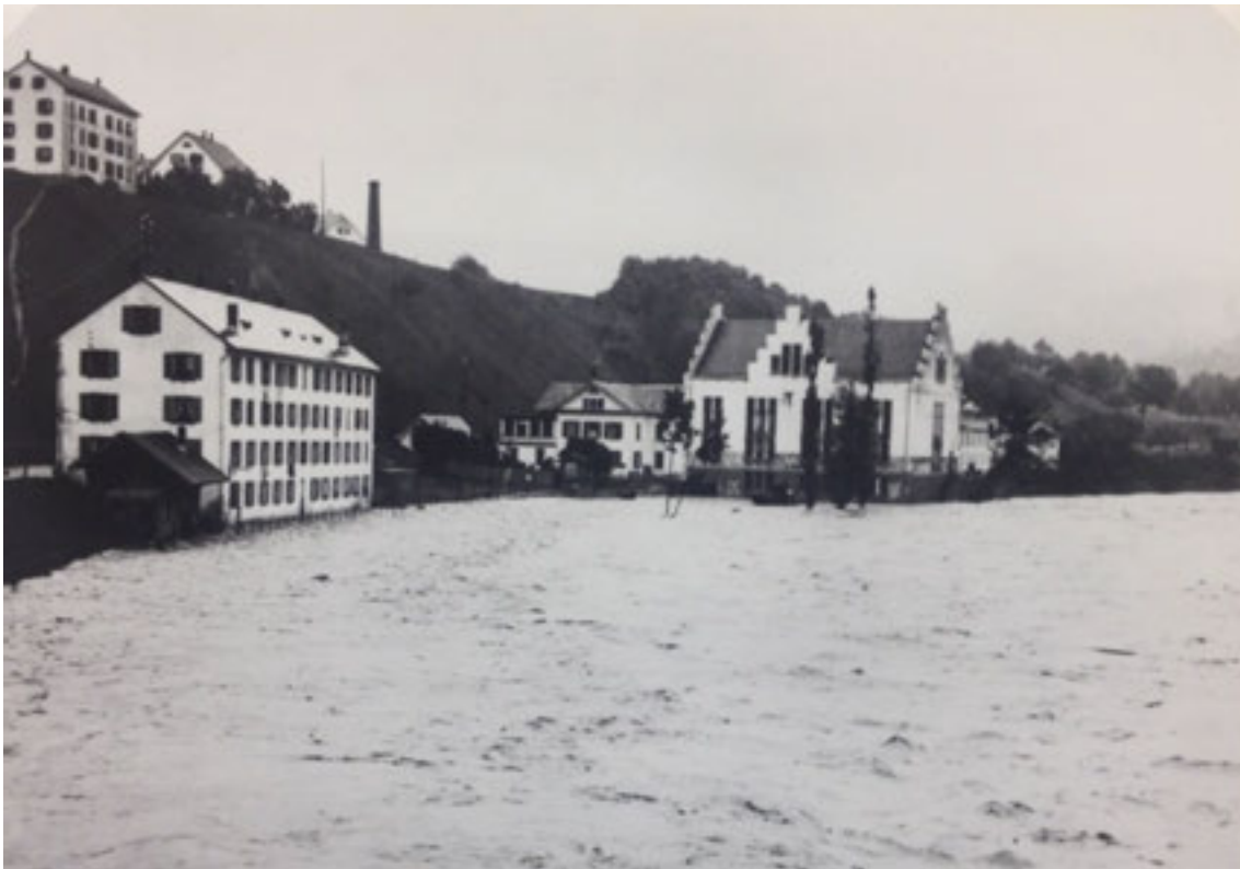
Abbildung 8, Kosthaus während des Hochwassers 1910 (Archiv Regionalwerke Baden, Fotoordner)
