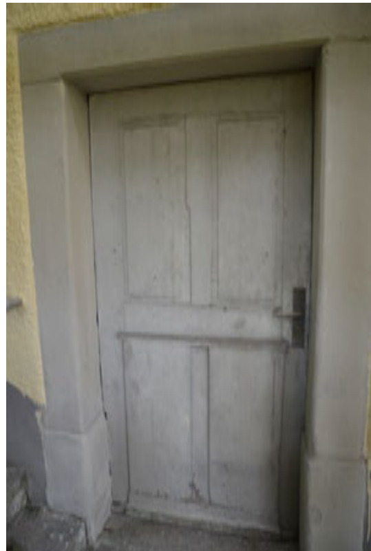
Abbildung 18 , nordseitiger Kellerzugang aus der Bauzeit (Foto H. Dobler Okt.2013)
