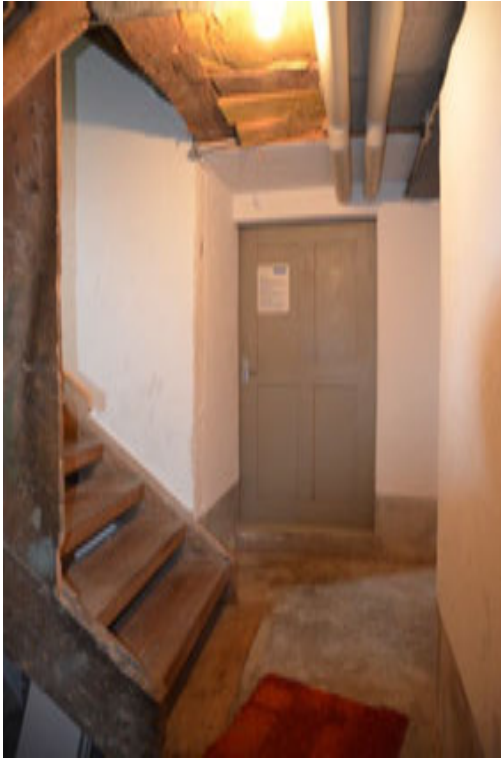
Abbildung 31 , Treppenabgang zum Keller mit noch erhaltener originaler Bausubstanz (Foto H. Dobler Okt.2013)
