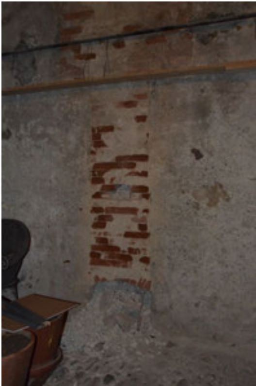
Abbildung 78 , zugemauerter Kaminschacht im ehemaligen Produktionsraum im Keller. (Foto H. Dobler, Jan.2015)
