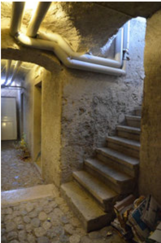
Abbildung 116, Treppe in den Keller. (Foto H. Dobler März 2015)
