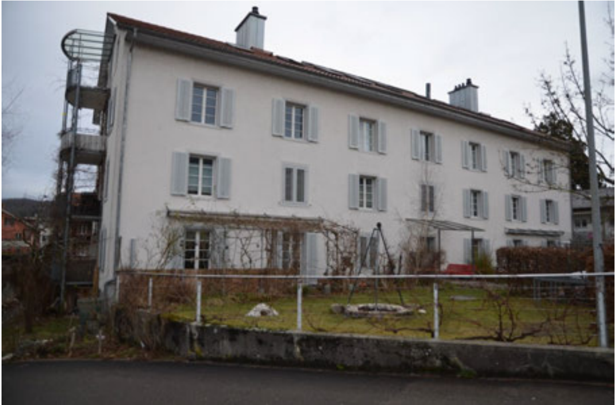
Abbildung 89 , Aufnahme Südfassade. (Foto H. Dobler Jan. 2015)
