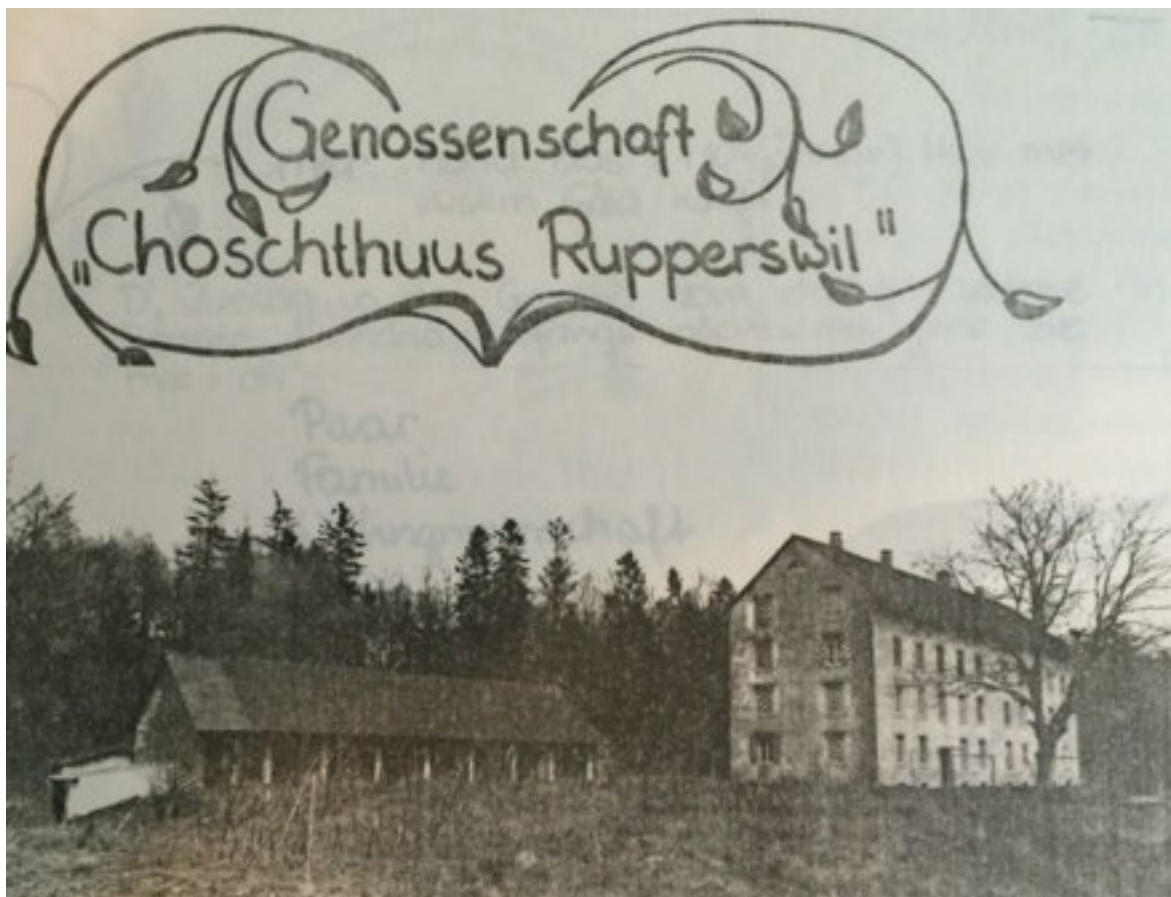
Abbildung 98, 99 Dem ersten Baugesuch beigelegt war eine liebevoll gestaltete Broschüre der neu gegründeten Genossenschaft Choschthuus, in welcher die grundsätzlichen baulichen Absichten und die Motivation dahinter dargelegt wurde. (Baugesucharchiv Ruppertswil)
