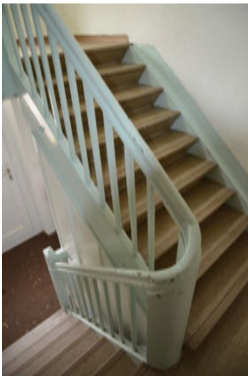
Abbildung 30 , Treppenhaus mit noch originalem, leider gestrichenem Geländer, Tritte mit PVC-Belag überzogen (Foto H. Dobler Okt.2013)
