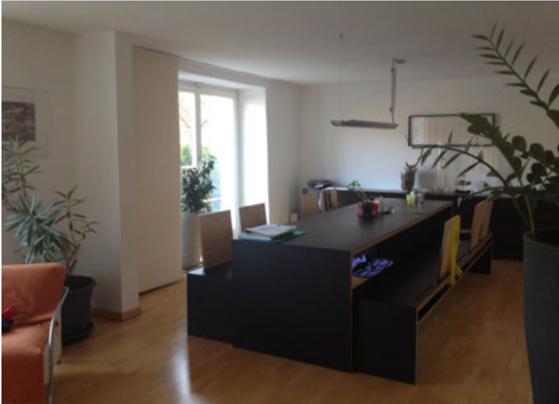
Abbildung 136, Blick in einen heutigen Wohnraum, die ursprüngliche Trennwand, welche die einzelnen Wohneinheiten teilte, ist noch im Ansatz in Form eines Mauerpfeilers lesbar, die Raumbreiten haben sich durch den Umbau verdoppelt. (Foto H. Dobler, März 2012)
