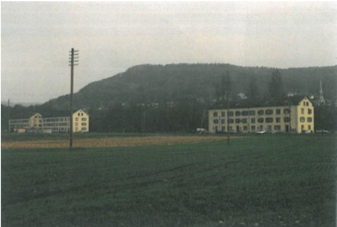
Abbildung 147 , Kosthäuser 2, 3 und 4 (von rechts) vor der Renovation. (Foto aus Kurzinventar Windisch Inv.Nr. 910B, 1994)
