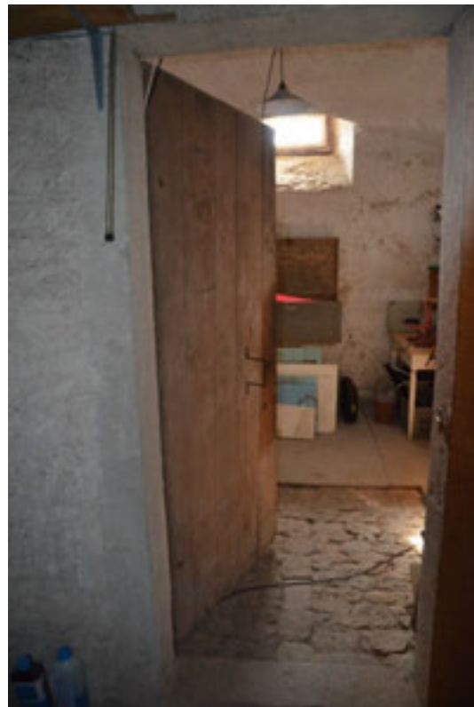
Abbildung 118, Kellerabteil mit Tonnengewölbe und Pflästerung. (Foto H. Dobler März 2015)
