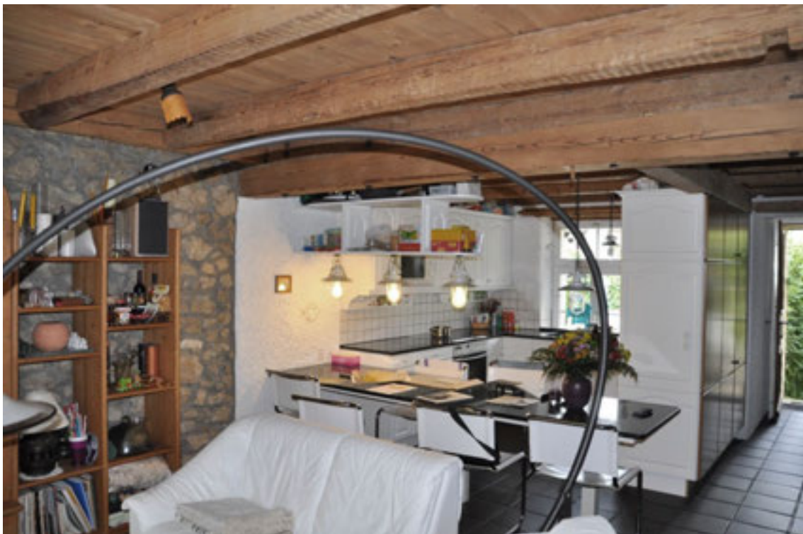
Abbildung 56 , Innenaufnahme Erdgeschoss, erhalten geblieben sind noch die Deckenbalken und ein Teil der Bodenbretter im OG (Foto H. Dobler August 2014)
