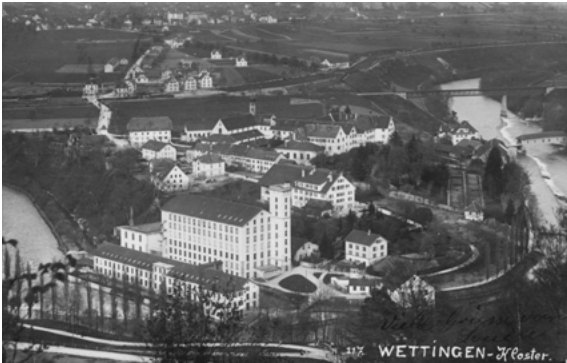
Abbildung 45 , Aufnahme F. Ruef-Hirt, Wettingen, Spinnerei- und Webereianlage Wild, zwischen dem sechsgeschossigen Spinnereigebäude und der langgezogenen niedrigen Weberei verläuft der heute zugeschüttete Oberwasserkanal, der bereits im 18. Jh. für die rechts sichtbare ehem. Klostermühle angelegt wurde. Im Hintergrund das Kosthaus mit Waschhaus (Digitales Fotoarchiv Wettingen, Signatur 20101013 12)
