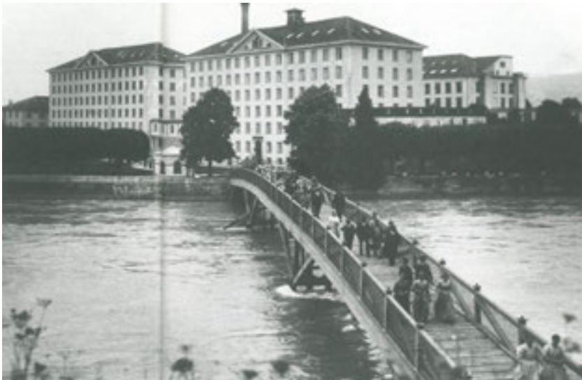
Abbildung 155, Die Verbindung von den Kosthäusern auf der Gebenstorfer Seite zum Fabrikareal in Windisch wurde über einen hölzernen Verbindungssteg bewerkstelligt, dieser wurde 1916 durch die heute noch bestehende Betonbrücke ersetzt. (Aufnahme um 1900, aus: Steigmeier, Sauerländer, Wohlhabenheit wird nur Wenigen zu Theil)
