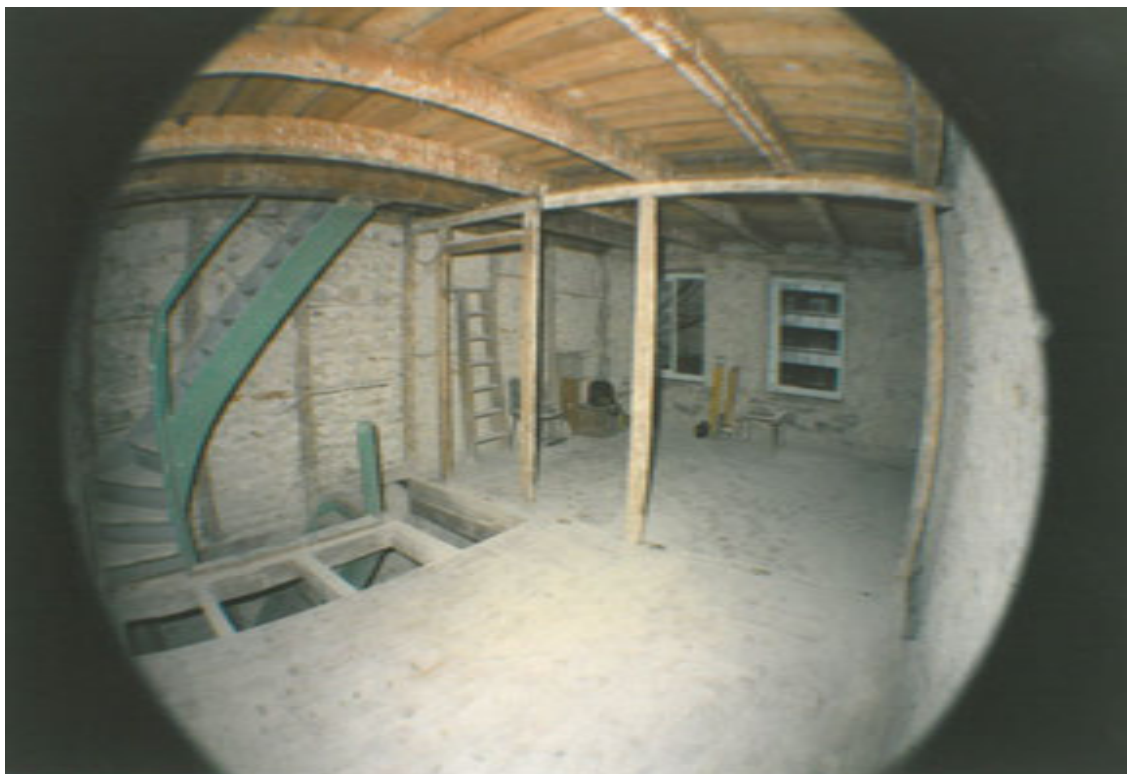
Abbildung 54 , Innenaufnahme des auf die Grundstruktur zurückgebauten Obergeschosses (Chlosterbrül 11), während der Renovation Mitte der 80er Jahre (Foto: R. Gartner, Eigentümer Chlosterbrül 11)
