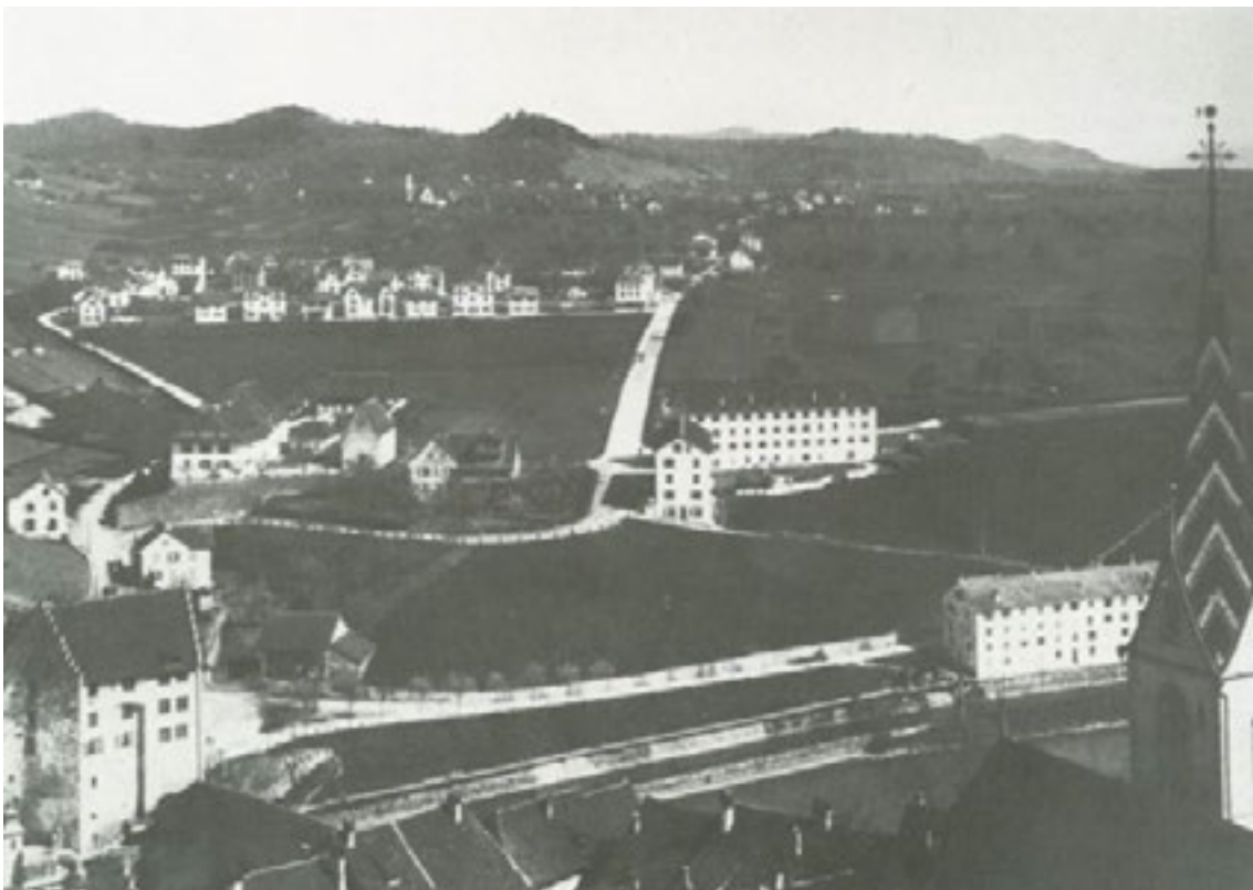
Abbildung 9, Foto Zisper 1897, links das Landvogteischloss, rechts das Kosthaus an der Kanalstrasse, im Hintergrund die beiden abgegangenen Kosthäuser.
