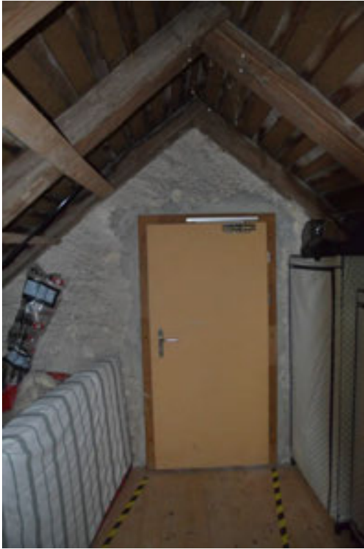
Abbildung 115, Estrichraum oberhalb des Kehlgebälks, Kaldach, eine Brandmauer teilt das Gebäude bis unter den First in zwei Hälften, später durchbrochen mit einer Fluchttüre. (Foto H. Dobler März 2015)
