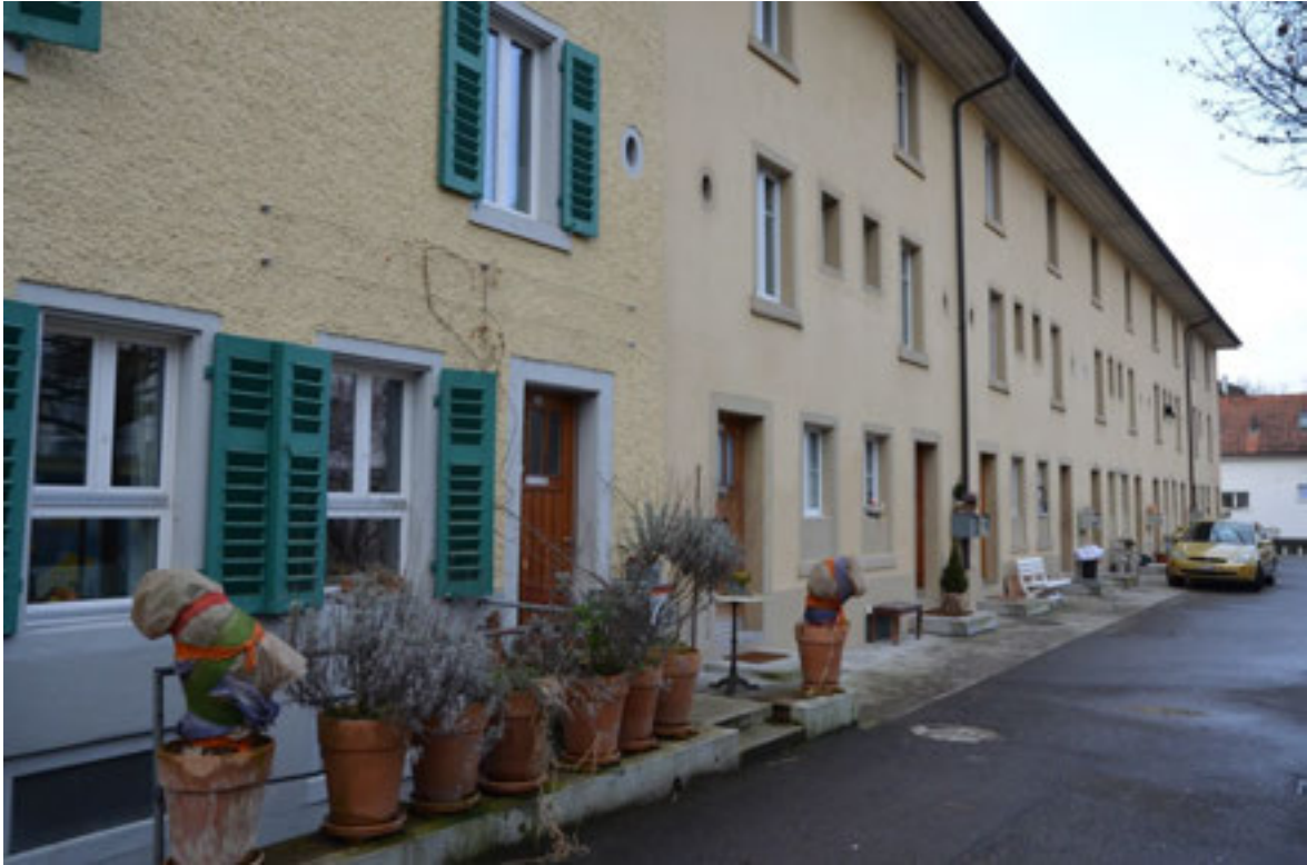
Abbildung 69 , Langhaus Nordfassade, der genossenschaftlich genutzte Teil im Osten hat das ursprüngliche Erscheinungsbild besser bewahrt, während sich der Bereich mit Eigentumswohnungen im Westen mit zusätzlichen kleinen Fensteröffnungen, glattem Putz und fehlenden Schlagläden differenziert. (Foto H. Dobler, Januar 2015).
