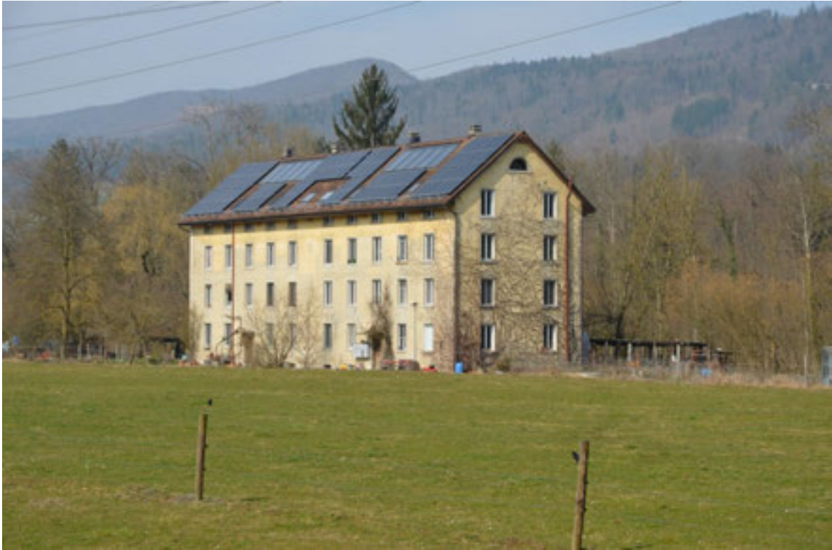
Abbildung 103 , Aufnahme Südostfassade. (Foto H. Dobler März 2015)
