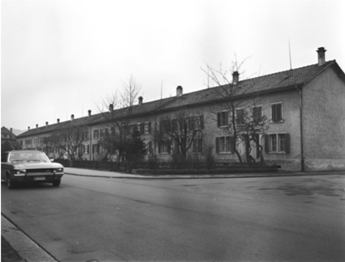
Abbildung 47 , Aufnahme von 1980, Walter Scherer, Baden, Kosthaus vor der Renovation (Digitales Fotoarchiv Wettingen, Signatur 19800226 12)
