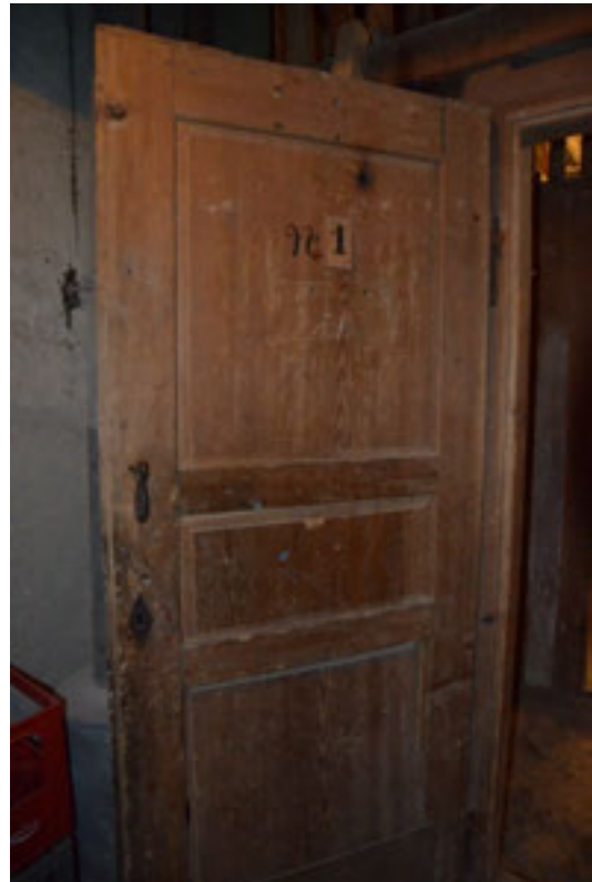
Abbildung 80 , bauzeitliche Türe mit Hausnummerierung zu Kellerabteil, abgeblattete und gestemmte Konstruktion. (Foto H. Dobler, Jan. 2015)
