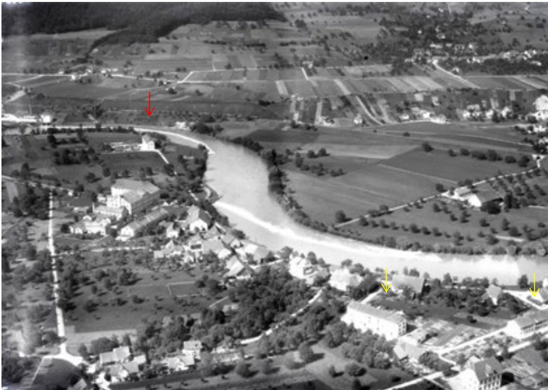
Abbildung 175, Flugaufnahme vor 1931, in der Bildmitte das kleine Bauerndorf, nördlich davon die Fabrikanlage und das noch bestehende Kosthaus (roter Pfeil). rechts zwei weitere Kosthäuser (gelber Pfeil) und der punktförmige Baukörper mit Krüppelwalmdach des Schulhauses von 1911. (ETH-Bibliothek Zürich, Bildarchiv, Fotograf Walter Mittelholzer).
