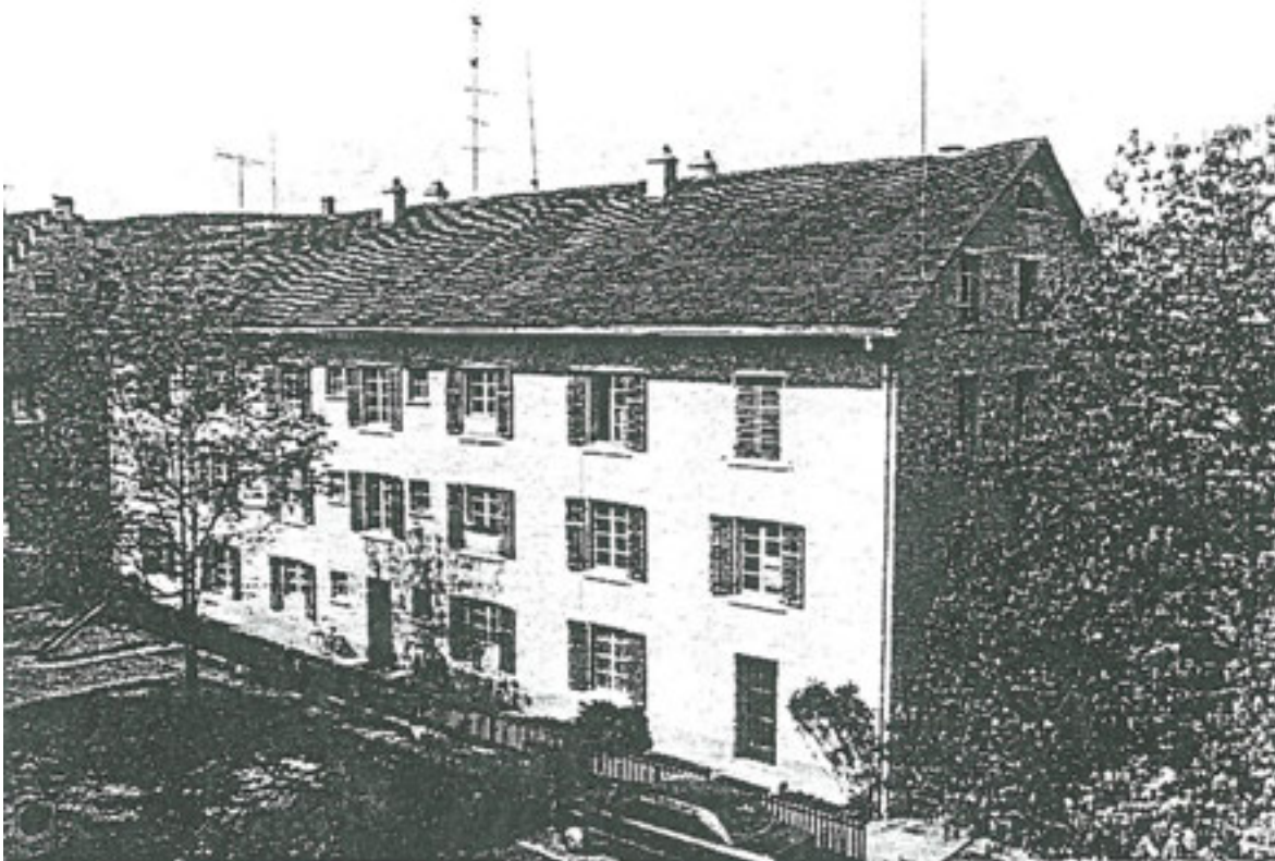
Abbildung 87 , Aufnahme von Südosten, vor der Renovation der 90er Jahre. (aus Kurzinventar Turgi)
