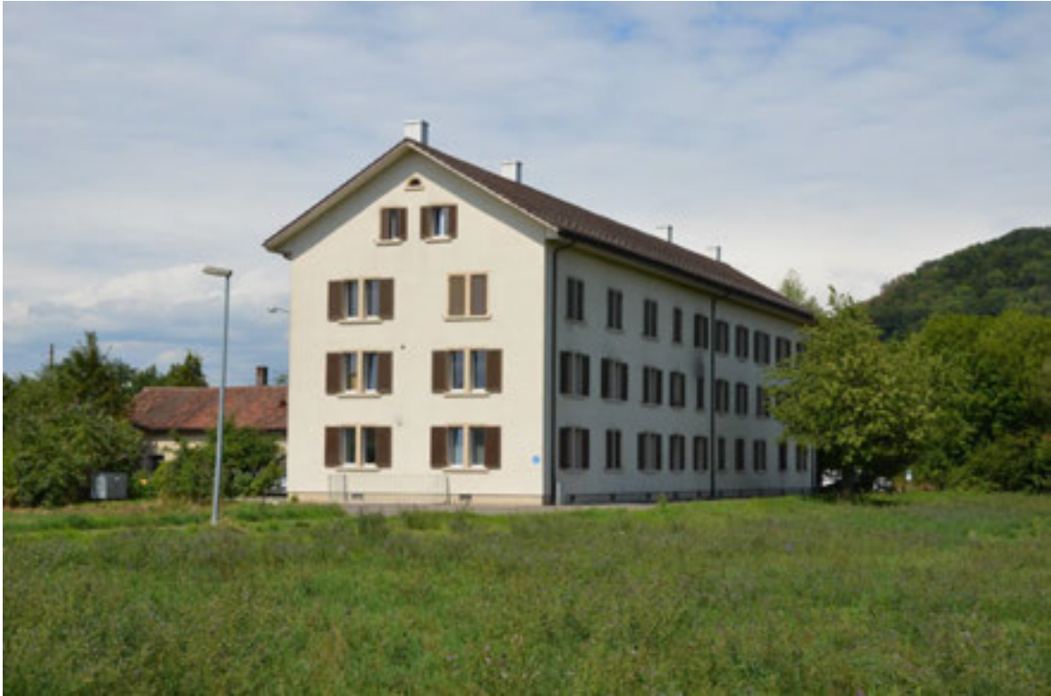
Abbildung 178 , renoviertes Kosthaus, links im Hintergrund erkennbar das zugehörige Waschhaus, Ansicht von Süden. (Foto H. Dobler, August 2015)
