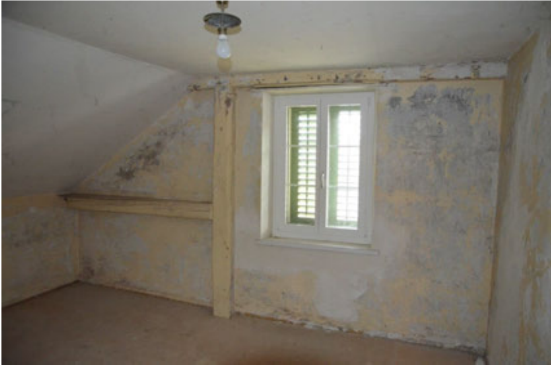
Abbildung 35 , Eine der vier im Dachgeschoss an der Giebelwand angefügten Kammern. (Foto H. Dobler Okt 2013)
