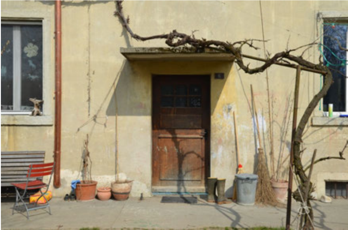
Abbildung 105 , Westlicher Eingang in der Südfassade mit bauzeitlicher Türe, neueres betoniertes feines Vordach. (Foto H. Dobler März 2015)
