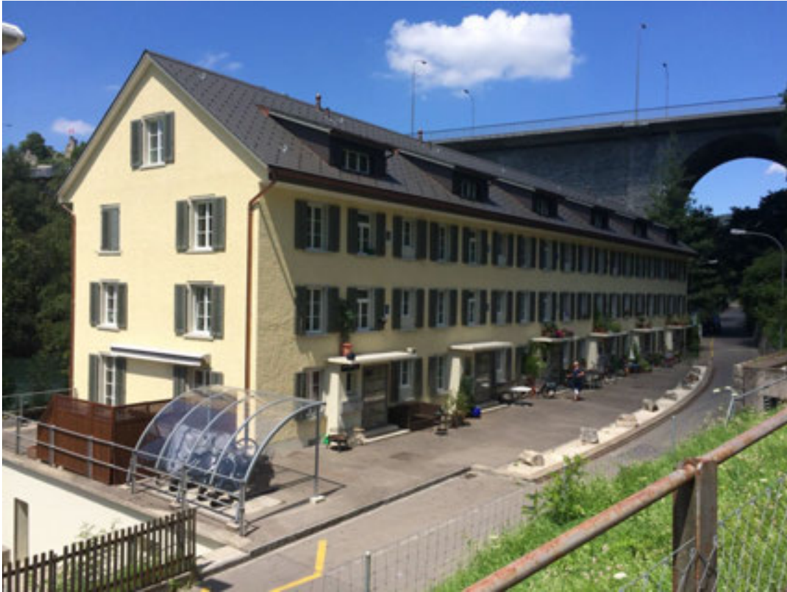
Abbildung 13 , Kosthaus nach der Sanierung (Foto H. Dobler, Juli 2014)
