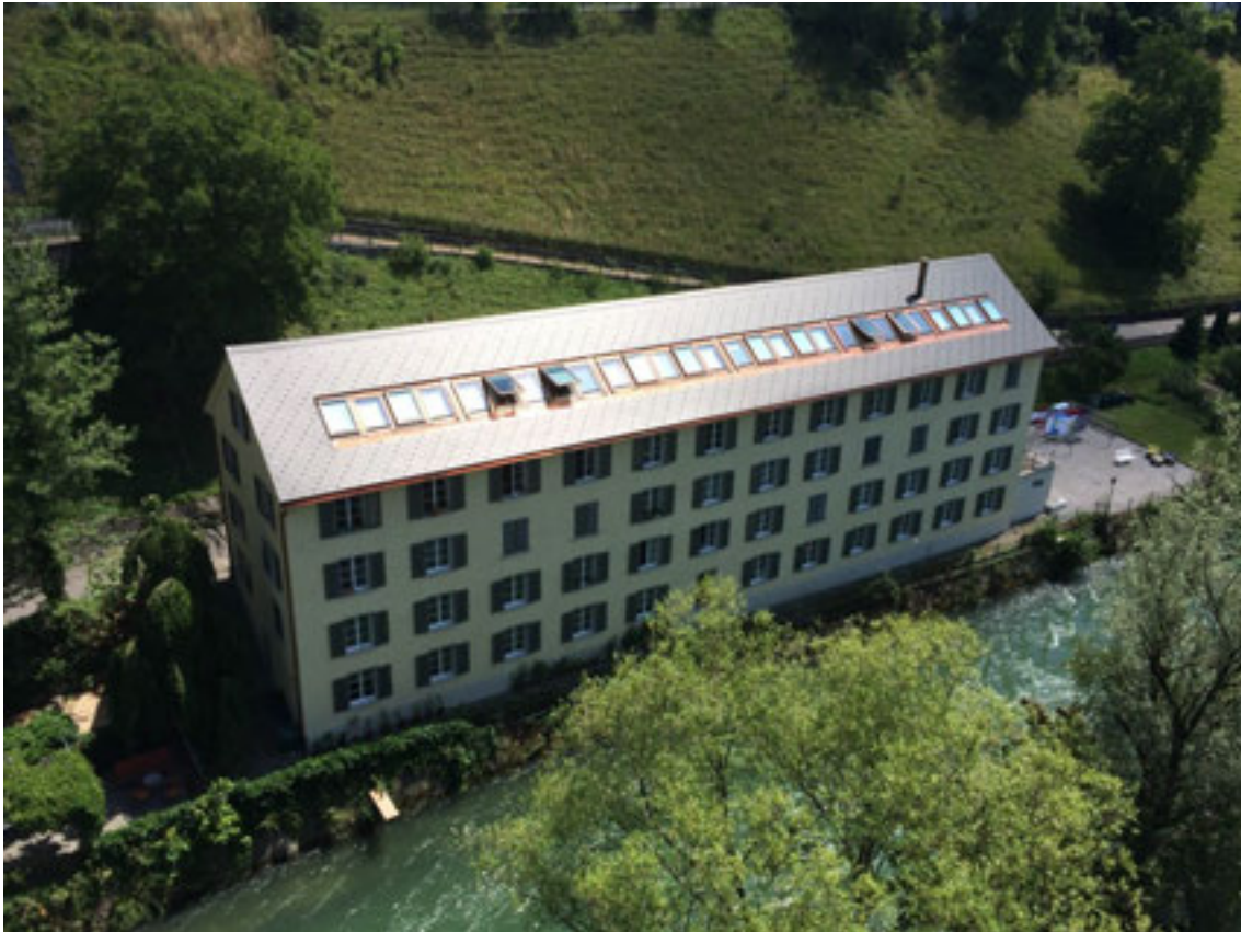
Abbildung 14 , Kosthaus nach der Sanierung 2013-14, das langgezogene Dachfensterband zeigt den Dachausbau überdeutlich (Foto H. Dobler, Juli 2014)
