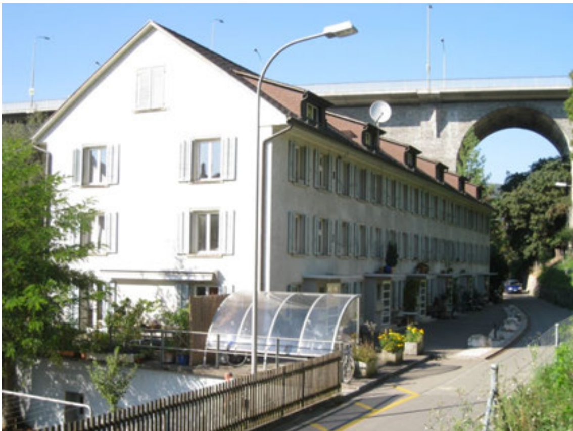
Abbildung 12 , Kosthaus vor der Sanierung 2013 (Foto H. Dobler Sept. 2011)
