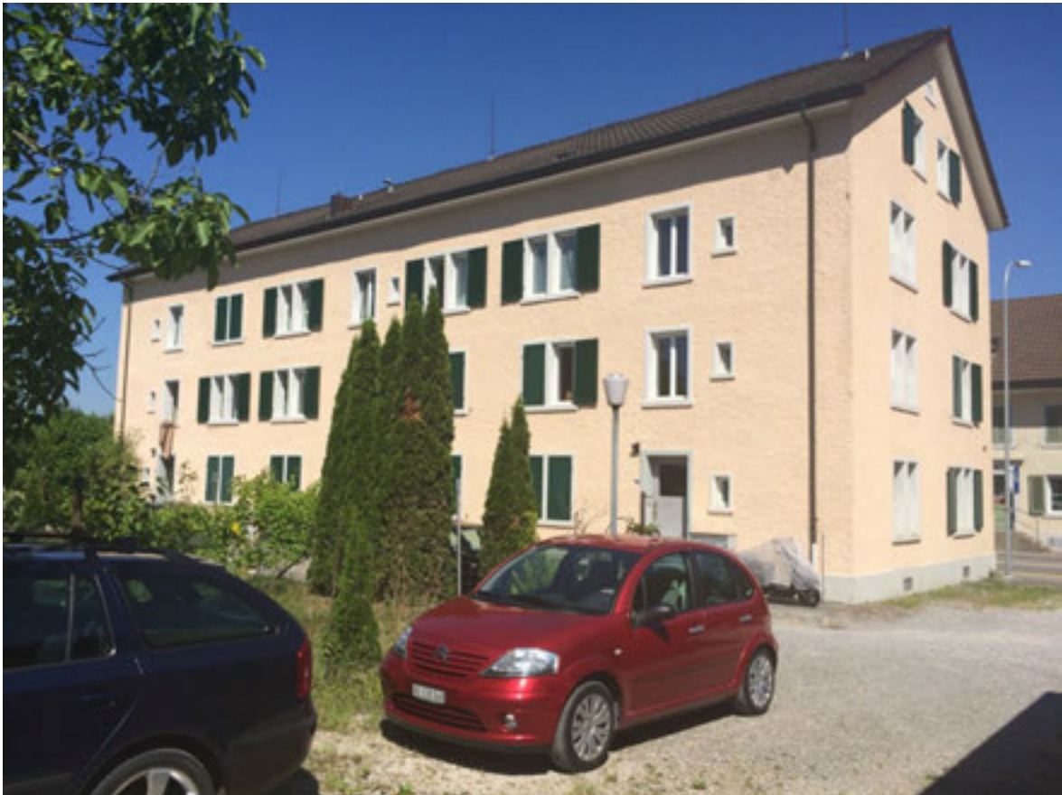
Abbildung 165 , Kosthaus Landstrasse 113-117 von Südosten. (Foto H. Dobler, Juni 2015)
