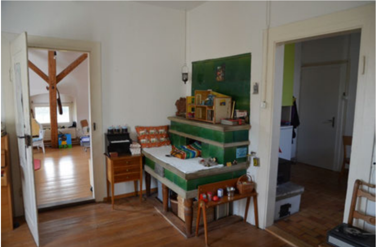
Abbildung 112 , bauzeitlicher Ofen, einfache neuere Tannenriemenböden, unter dem Ofen haben sich noch die ursprünglichen Dielen erhalten. (Foto H. Dobler März 2015)
