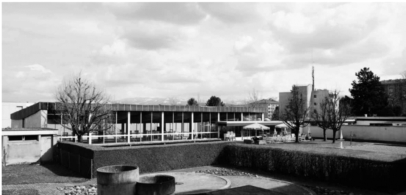
Abbildung 26: Westansicht des Hallenbads. Der Garten ist direkt vom Hallenbad aus zugänglich.
