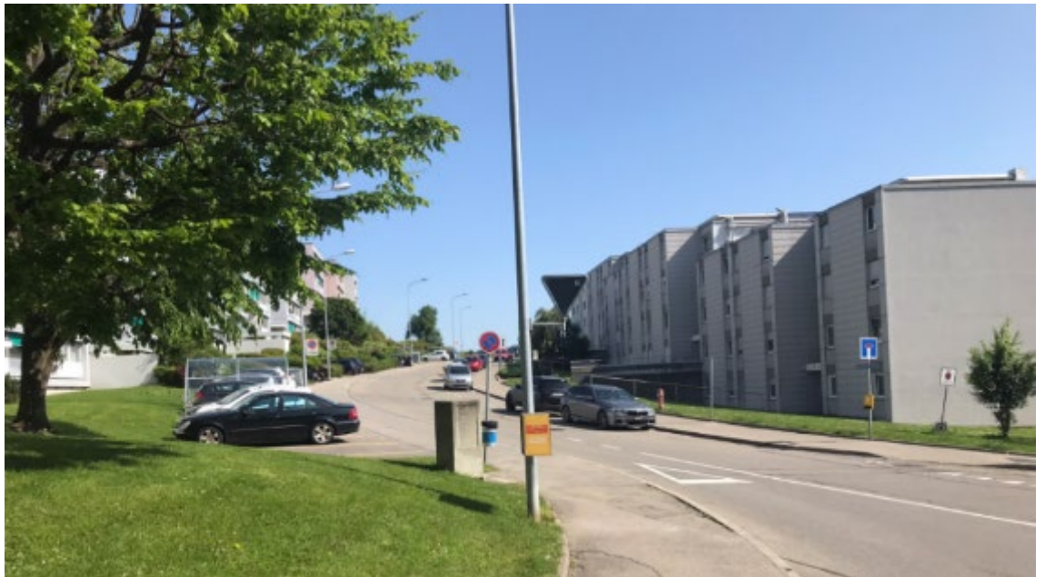
Abbildung 37: Eine Zufahrtsstrasse zur Überbauung in ihrem aktuellen Zustand.
