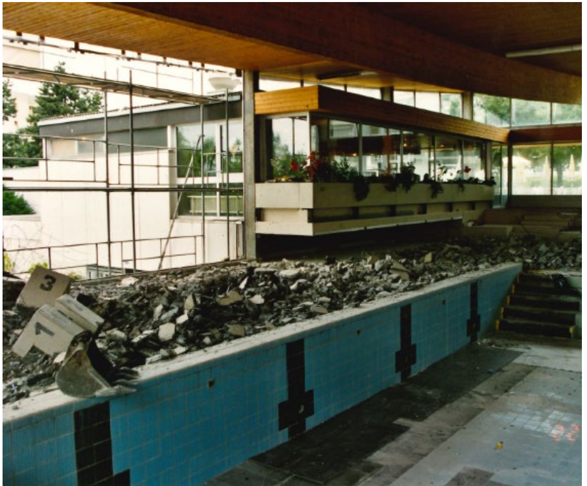
Abbildung 32: Sanierungsarbeiten im Hallenbad, Juli 1999.
