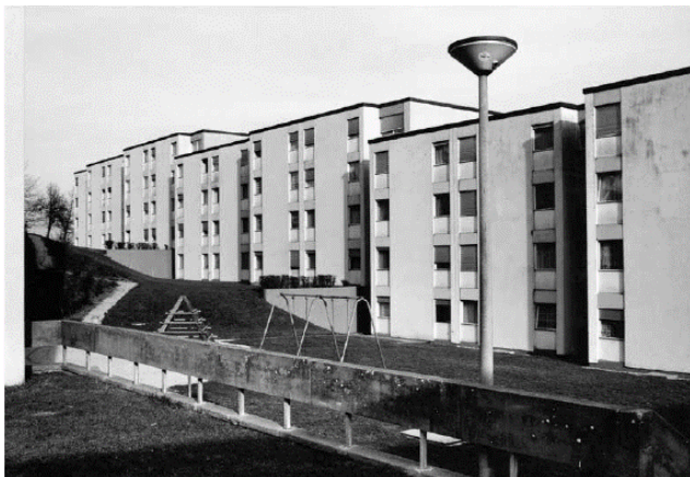
Abb. 29 und 30: Links: Die rückseitige Fassade der Wohnzeilen vor der Umgestaltung. Rechts: Die gleiche Fassade nach den energetischen Sanierungsarbeiten. Zu bemerken ist die ursprüngliche Vertikalität der Fassade, die bei der energetischen Sanierung nicht berücksichtigt wurde.
