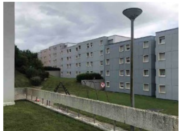
Abb. 29 und 30: Links: Die rückseitige Fassade der Wohnzeilen vor der Umgestaltung. Rechts: Die gleiche Fassade nach den energetischen Sanierungsarbeiten. Zu bemerken ist die ursprüngliche Vertikalität der Fassade, die bei der energetischen Sanierung nicht berücksichtigt wurde.
