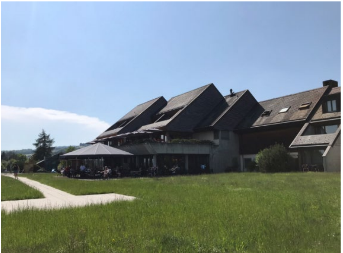
Abbildung 12: Motel de la Gruyère in Avry-devant-Pont. Juni 2023.
