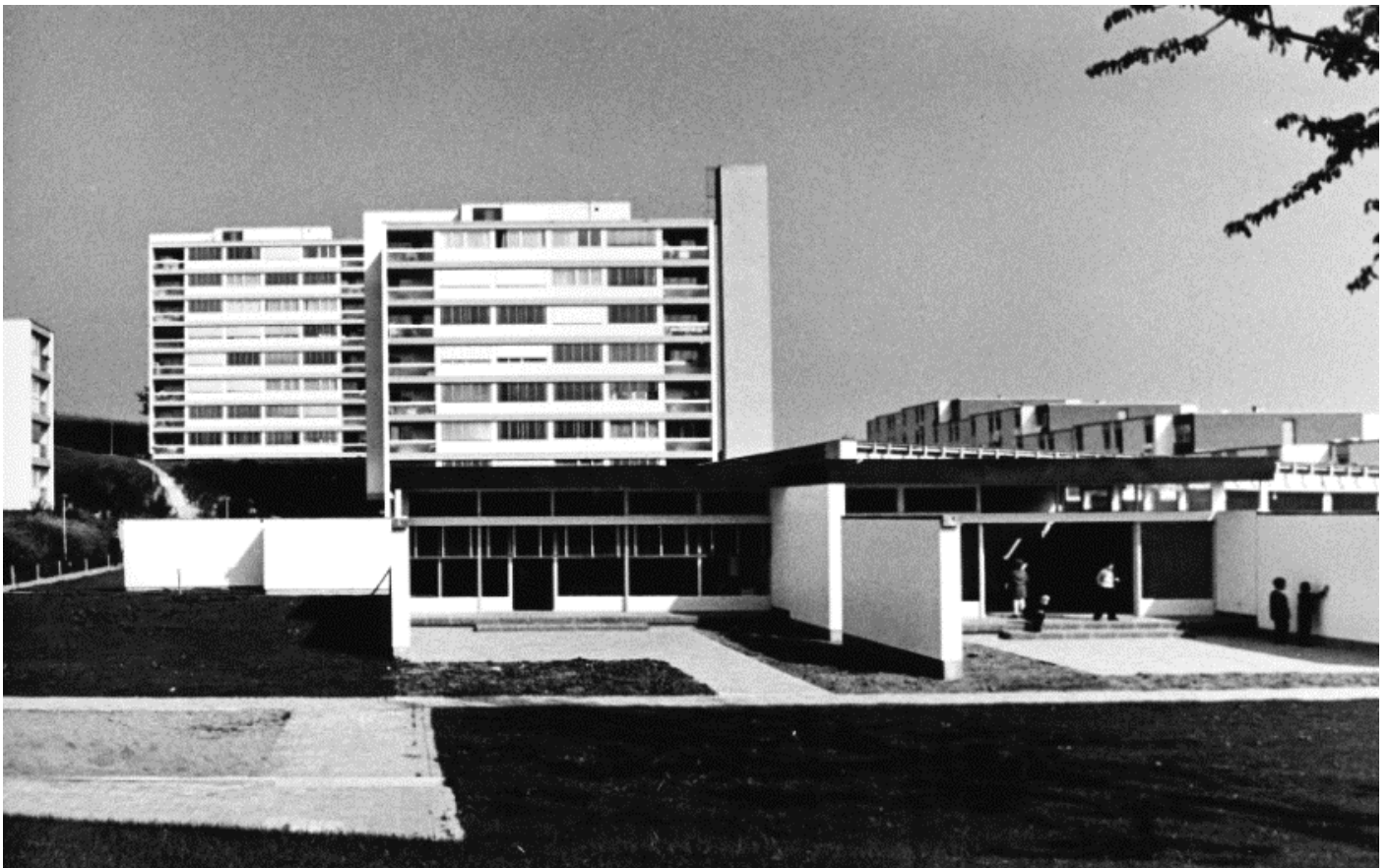
Abbildung 23: Die Kinderkrippe mit den Wohntürmen im Hintergrund. Rechts des vorderen Hochhauses ist der monumentale Kamin der Heizzentrale zu sehen.
