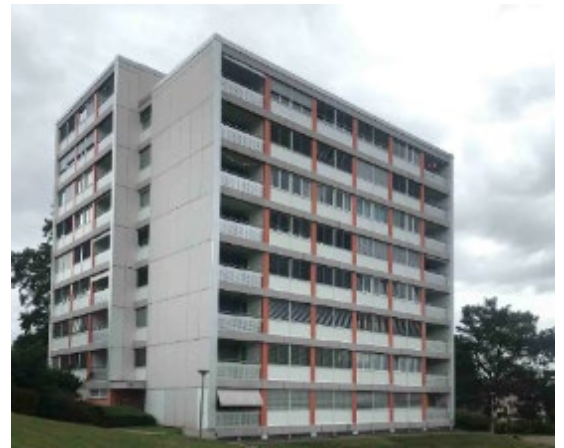
Abb. 31 und 32: Links: Die ursprüngliche Fassade der Wohntürme. Rechts: Der heutige Zustand. Auf den Fassaden der Türme wurden Farbstreifen angebracht und die transluzenten Geländer der Loggien wurden durch Metallelemente ersetzt.
