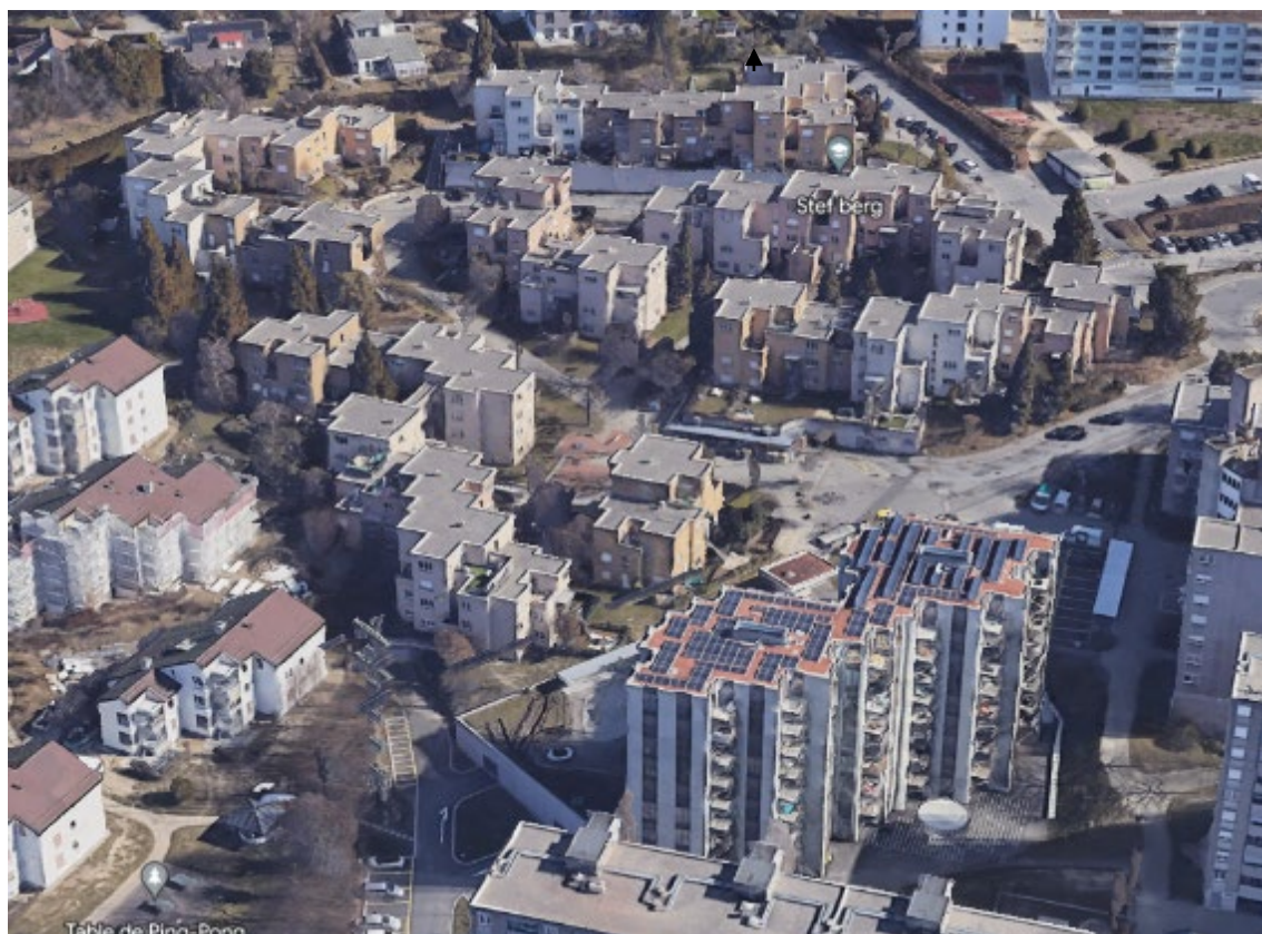
Abbildung 56: Luftaufnahme der Überbauung Grangette-Praz-Séchaud . Unten ist das im Bau befindliche Verdichtungsprojekt zu sehen. ▲ N
