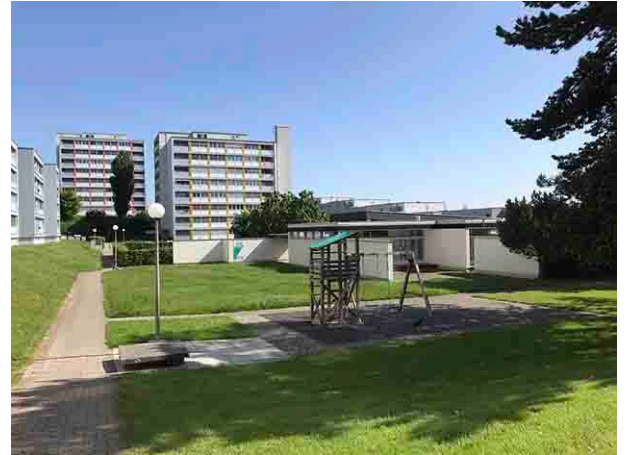
Abbildung 72: Die Grünfläche oberhalb der Tiefgarage.
