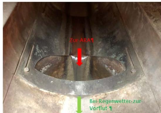
Leapingwehr: Beim Überschreiten der kritischen Abflussmenge wird das restliche Abwasser in die Vorflut abgeleitet
