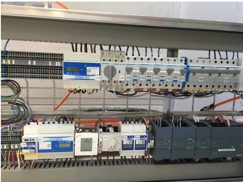
Abbildung 7 Einer von 5 Verteilerkästen zur Unterbringung der Messhardware
