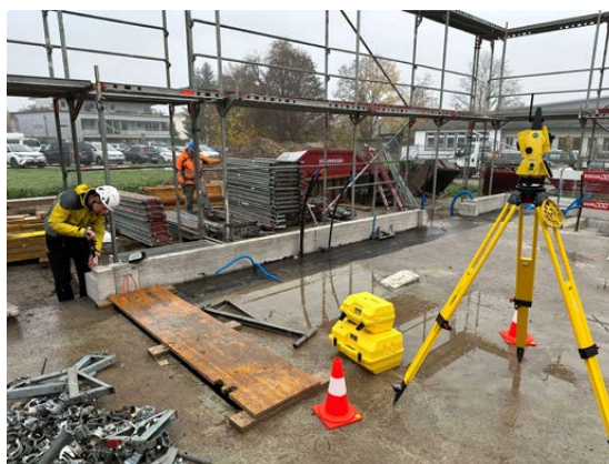
Abstecken mit einem Robotik-Tachymeter
