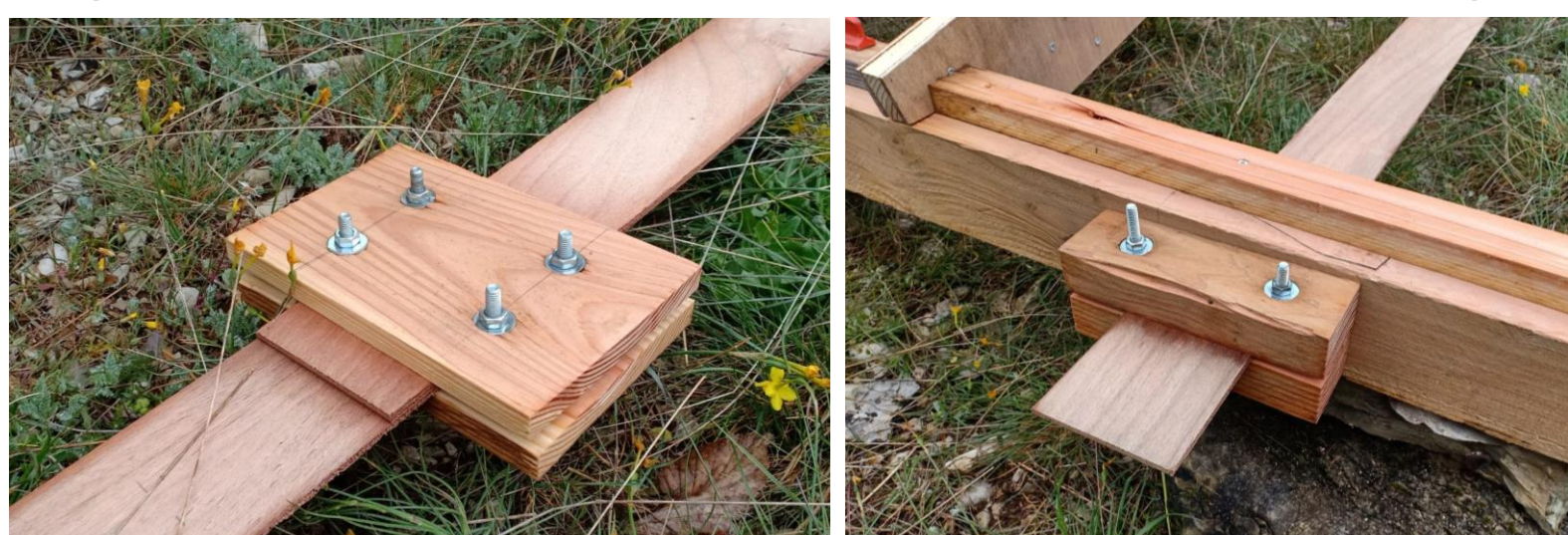
Verbindung beim Zugband
