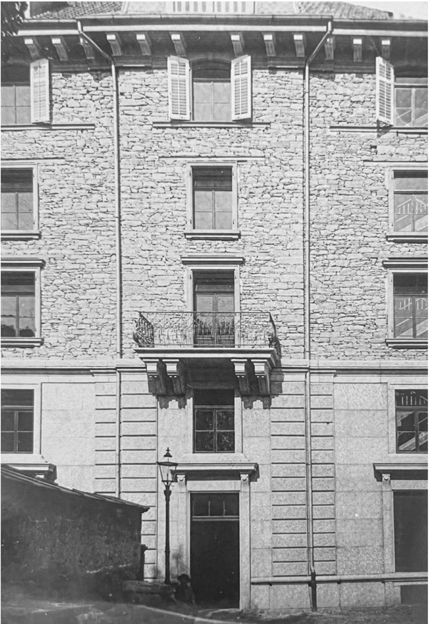
Abb. 36 vorherige Seite: Fassade Eisenwarenmagazin Biemann & Cie an der Baselstrasse Nr.12 um 1903 (1971 abgebildet). Das Bruchsteinmauerwerk über dem Sockel ist noch unverputzt ersichtlich. Fotograf unbekannt (LSa 44: Luzern Stadt, Biemann & Cie, Baselstrasse).
