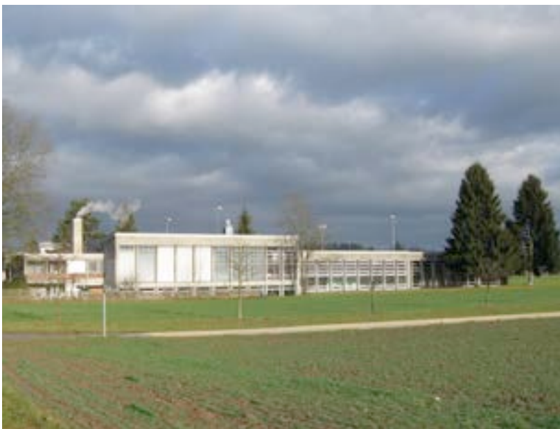
Abb. 87: Werner Küenzi, Schulanlage Byfang, Thunstetten, 1972, Turnhalle. (Foto: M. D'Alessandro, 29.12.2011)
