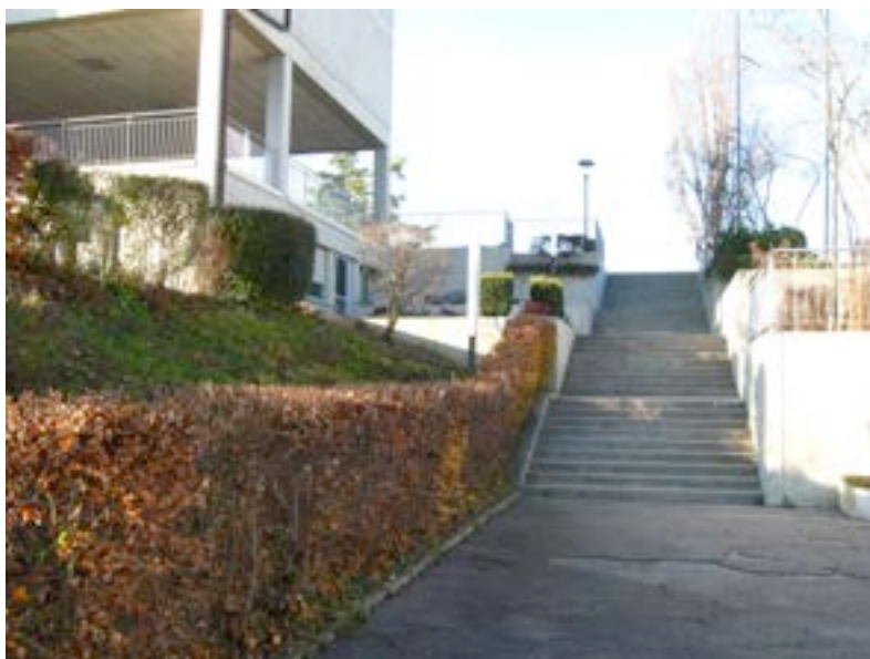
Abb. 38: Werner Kuenzi, Schulanlage Selhofen, Kehrsatz, 1969-72, südlicher Zugang zum Sekundarschulhaus, der im Pausenplatz mündet. (Foto: M. D'Alessandro, 18.11.2011)
