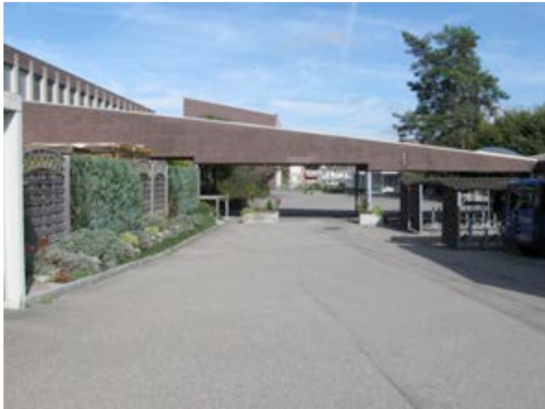
Abb. 36: Werner Kuenzi, Schulanlage Jegenstorf, 1968, westlicher Zugang. (Foto: M. D'Alessandro, 12.10.2011)
