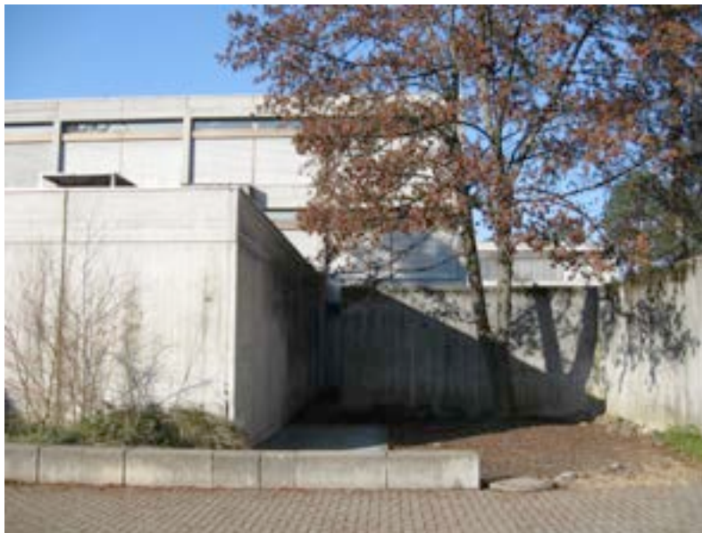
Abb. 72: Werner Künzi und Willy Brechbühl, Schulanlage Kirchenfeld, Lyss, 1974, Nischen im Aussenraum. (Foto: M. D'Alessandro, 27.12.2011)
