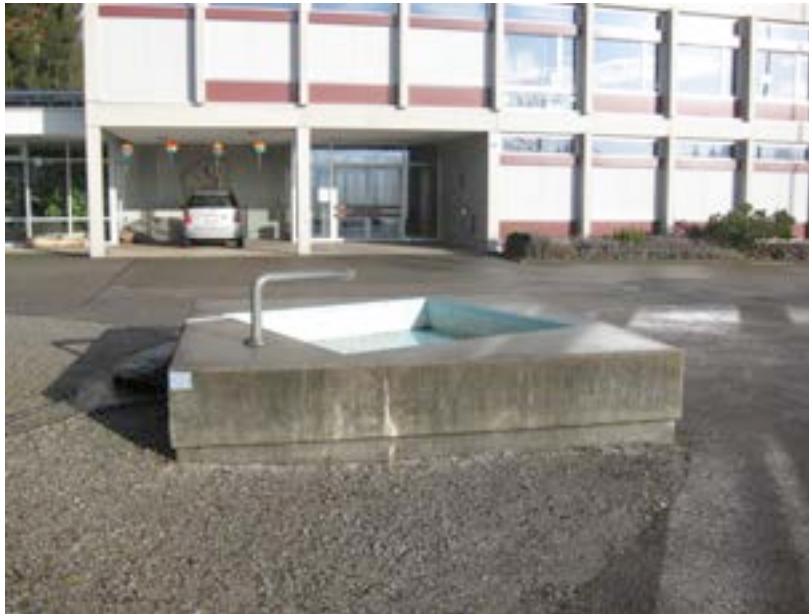
Abb. 95: Werner Küenzi, Schulanlage Byfang, Thunstetten, 1972, Turnhalle. (Foto: M. D'Alessandro, 29.12.2011)
