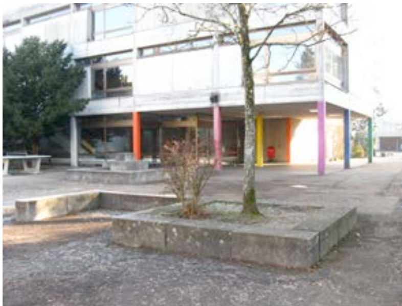
Abb. 69: Werner Künzi und Willy Brechbühl, Schulanlage Kirchenfeld, Lyss, 1974, Aussenraummöblierung des Pausenplatzes. (Foto: M. D'Alessandro, 27.12.2011)
