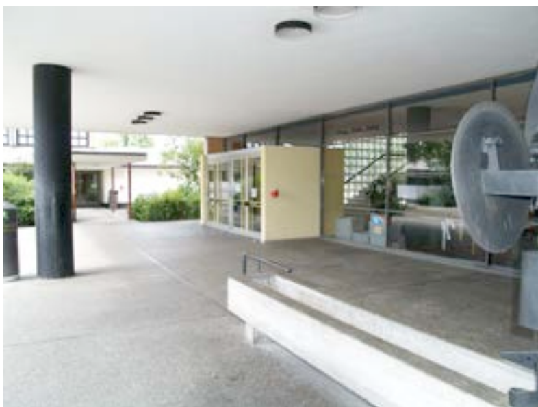
Abb. 47: Werner Künzi, Schulanlage Rossfeld, Bern, 1954-56, gedeckter Pausenhof der Sekundarschule mit Brunnen, Bodenbelag aus Waschbetonplatten, Deckenlampen und vortretendem Windfang. Die verglaste Wand erlaubt den Blick ins Treppenhaus mit den Glasbausteinen. Am rechten Bildrand die Brunnenskulptur von Bernhard Luginbühl und im Hintergrund der Laufgang zur Turnhalle. Links im Bild eine schwarze Betonsäule, deren Pendant im Inneren steht. (Foto: M. D'Alessandro, 17.06.2011)
