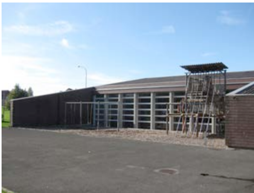
Abb. 85: Werner Künzi, Schulanlage Jegenstorf, 1968, Turnhalle. (Foto: M. D'Alessandro, 12.10.2011)
