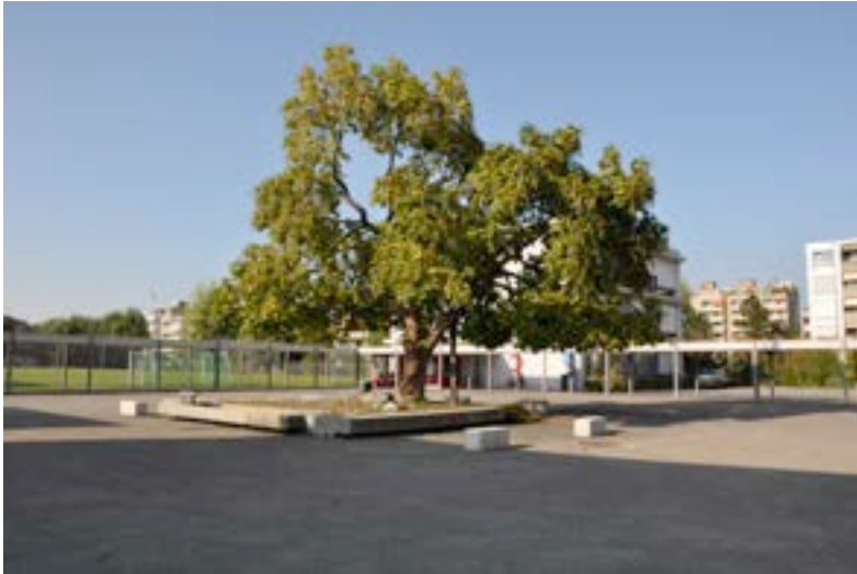
Abb. 48: Werner Künzi, Schulanlage Mörsli, Ostermundigen, 1959-68, Pausenhof mit umgehendem Laufgang. Platzgestaltung mit Trompetenbaum auf der Plattform mit integriertem Brunnen. (Foto: M. D'Alessandro, 29.09.2011)
