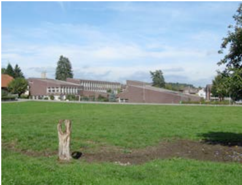
Abb. 11: Werner Kuenzi, Schulanlage Gegenstorf, 1968. (Foto: M. D'Alessandro, 12.10.2011)
