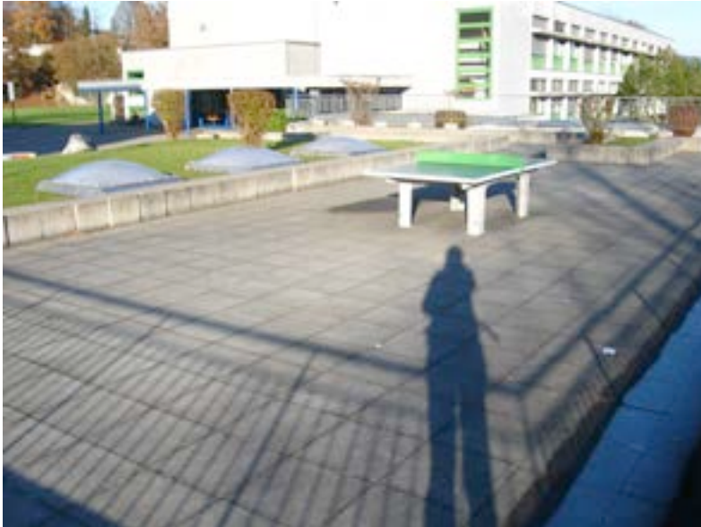
Abb. 60: Werner Künzi, Schulanlage Selhofen, Kehrsatz, 1969-72, begehbare, erneuertes Auladach als Bestandteil des Pausenplatzes. (Foto: M. D'Alessandro, 18.11.2011)
