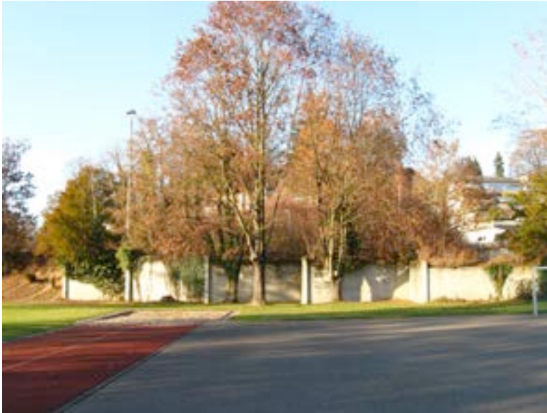
Abb. 66: Werner Küenzi, Schulanlage Selhofen, Kehrsatz, 1969-72, Stützmauern vor der Böschung. (Foto: M. D'Alessandro, 18.11.2011)
