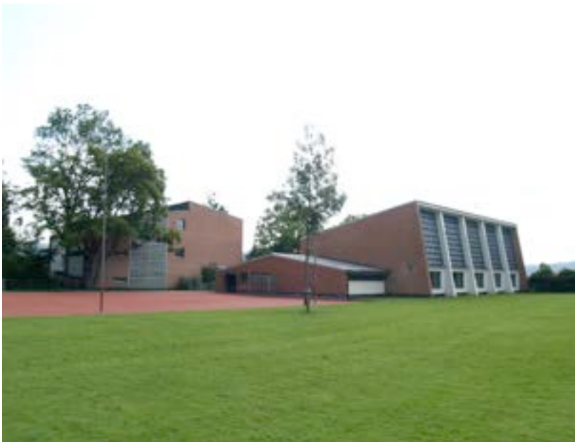
Abb. 81: Werner Kuenzi, Schulanlage Rossfeld, Bern, 1954-56, Turnhalle. (Foto: M. D'Alessandro, 17.06.2011)
