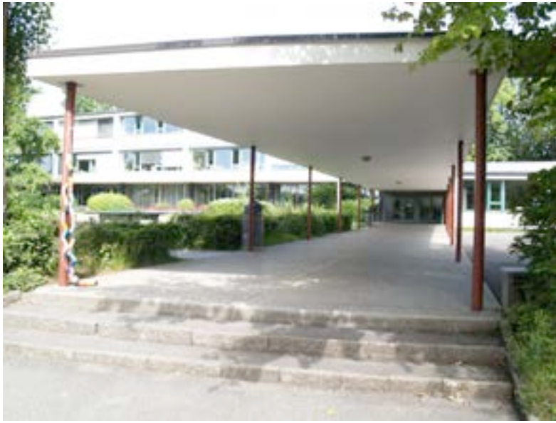
Abb. 29: Werner Kuenzi, Schulanlage Rossfeld, Bern, 1954-56, Laufgang. (Foto: M. D'Alessandro, 17.06.2011)
