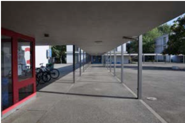
Abb. 30: Werner Kuenzi, Schulanlage Mösli, Ostermundigen, 1959-68, Laufgang. (Foto: M. D'Alessandro, 29.09.2011)
