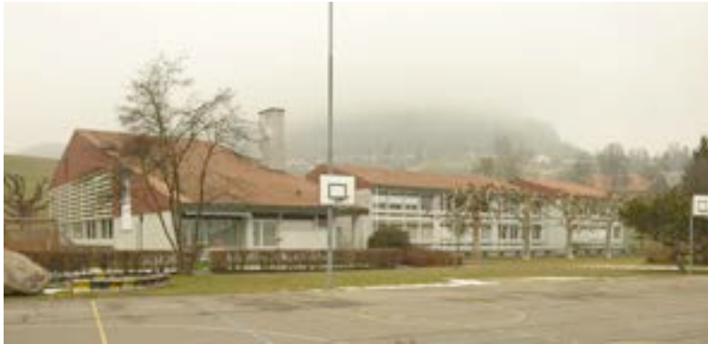
Abb. 10: Werner Kuenzi, Schulanlage Vechigen, 1961/62. (Foto: Mathias Walter, 5.2.2007)
