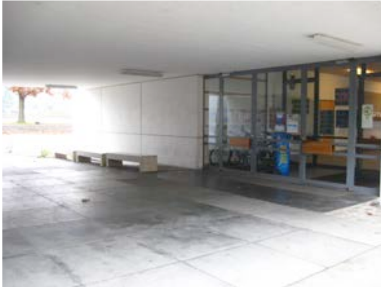
Abb. 51: Werner Künzi, Schulanlage Schwabgut, Bern, 1959-67, gedeckter Pausenhof der Primarschule. (Foto: M. D'Alessandro, 11.11.2011)
