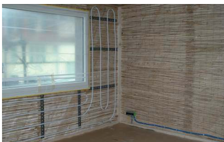
Abbildung 4: Wandaufbau mit Schilfmatten,
