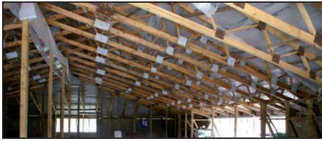
Fachwerkbinder am First unterstellt
