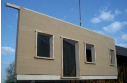
Neubau EFH in Holzsystembau
