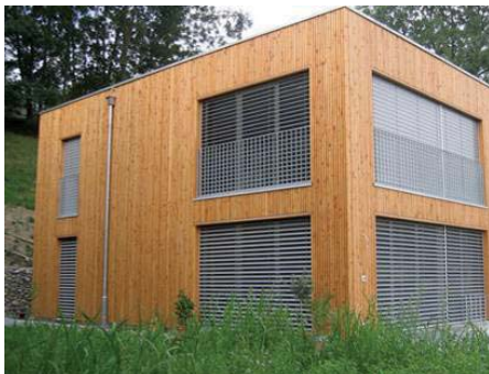
Abbildung 3: Ansicht Fassade mit Aussenstoren als Sonnenschutz
