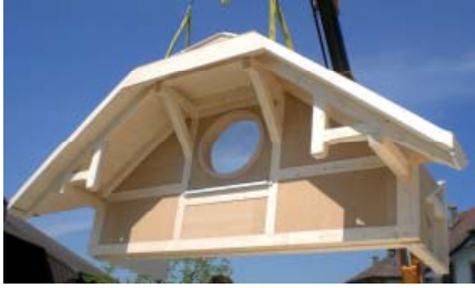
Aussenwand in Holzsystembauweise
