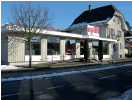
Küchenausstellung mit Bürogebäude
