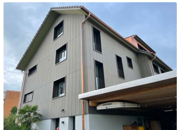
Erstes Referenzobjekt mit unbeschichteten CDF-W-Holzfaserverplatten
